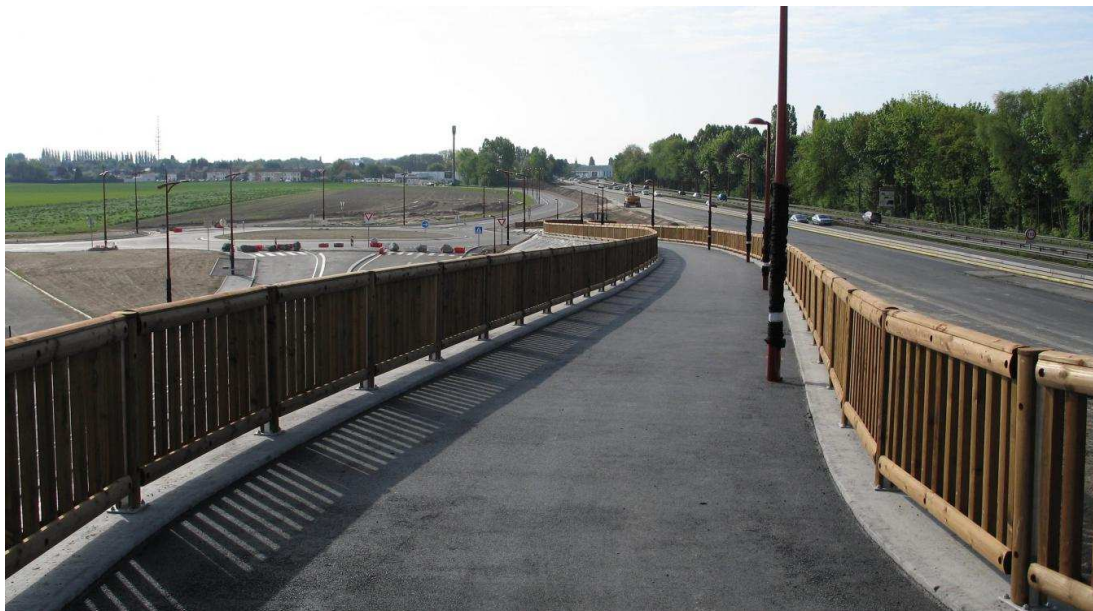
Nouvelle passerelle piétonne traversant l'A23
