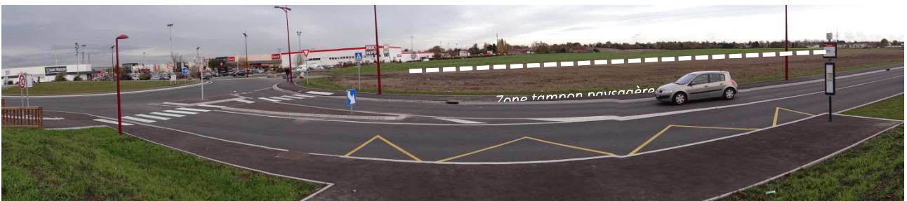
Vue d'ensemble de l'espace agricole
