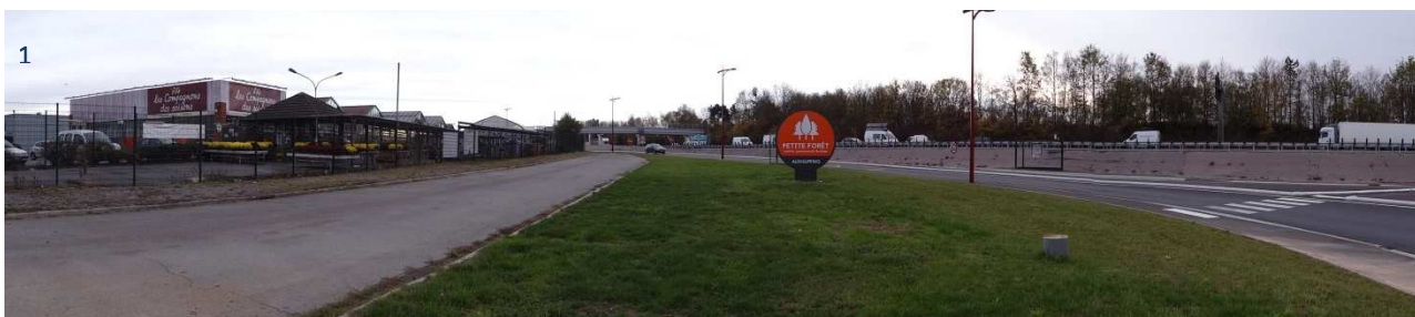
Perception la zone d'activité (jardinerie amenée à disparaître) depuis le giratoire du carrefour de la rue du 19 mars 1962 et de la rue du Boussingault
