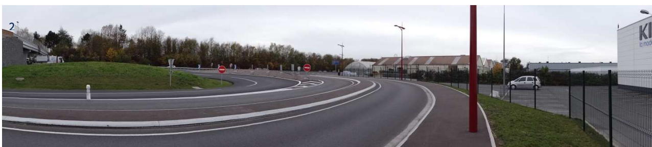
La nouvelle bretelle d'accès au niveau de la passerelle Arthur Musmeaux
