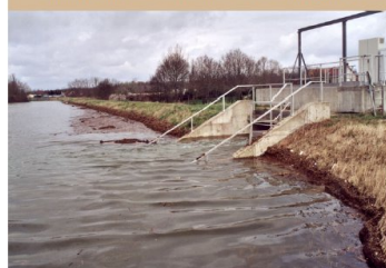
La digue d'Ouroux-sur-Saône (71)
