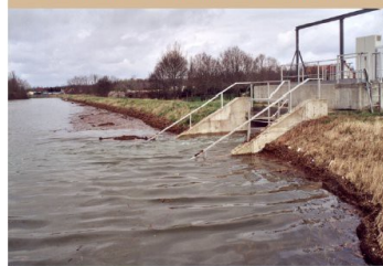
La digue d'Ouroux-sur-Saône (71)
