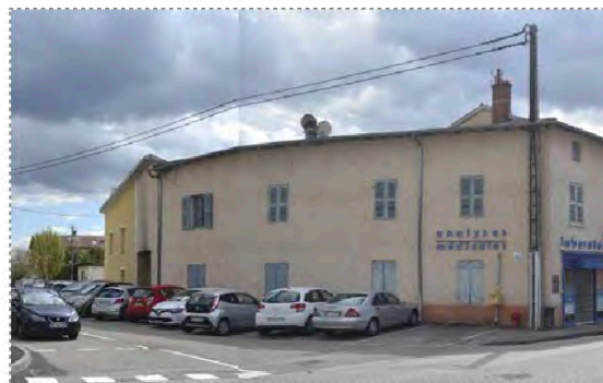
(2) Carrefour Route de Genève - Impasse des Peupliers - Sur largeur voirie donnée au stationnement automobile au détriment de circulation piétonne.
