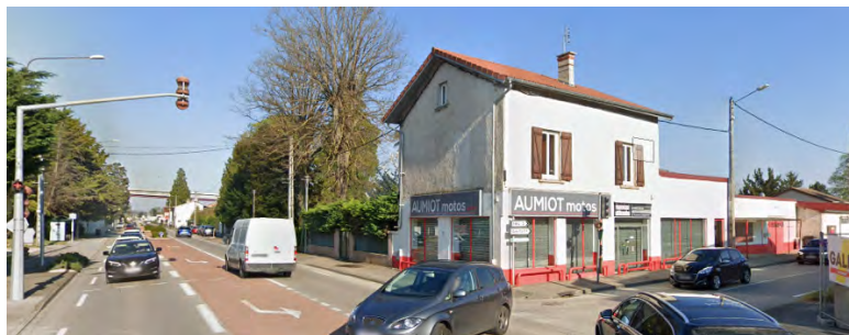
Angle de la Route de Genève et de l'avenue de la Gare
