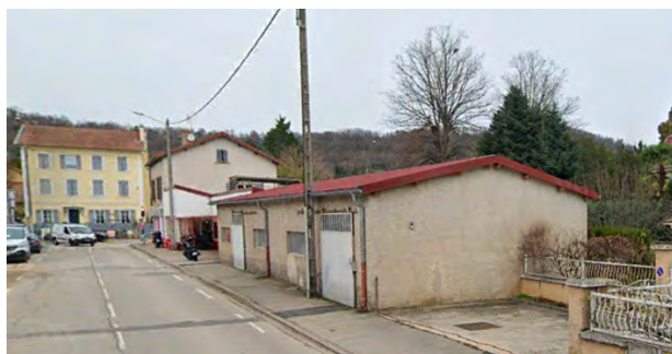
Garage–Avenue de la Gare
