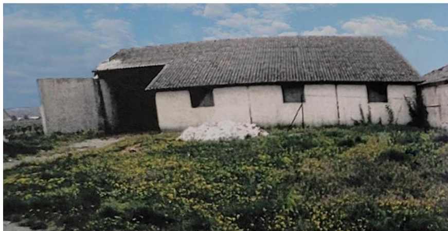
Photographie du hangar agricole
