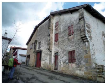
N°114 - Maisons d'Ostabat avec refends à encorbellements (cl. G.-H. Bailly)
