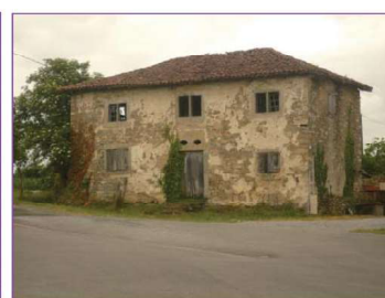
N°58 - une maison ancienne inhabitée de Larribar-Sorhapuru (cl. G.-H. Bailly)
