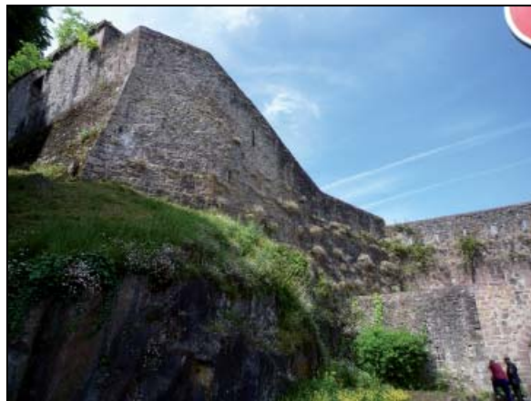
Vue des remparts au-dessus et au sud de la porte (cl. G.-H. Bailly)
