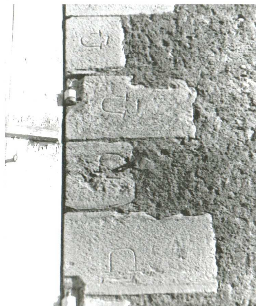
ENDUIT A PIERRE VUE
