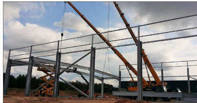
Hier matin, trois mâts ont débuté la pose de la structure métallique des 3 000 m² d'ateliers de Car-Itex.
