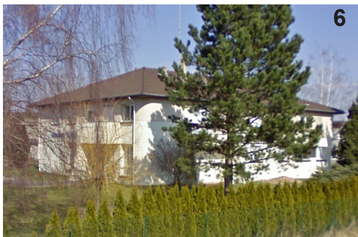
Pavillon de type toit à quatre pans dans la zone d'activité
