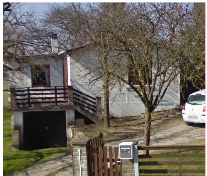
2 Maison individuelle de plain pied avec soubassement pour le garage et toit à deux pans
