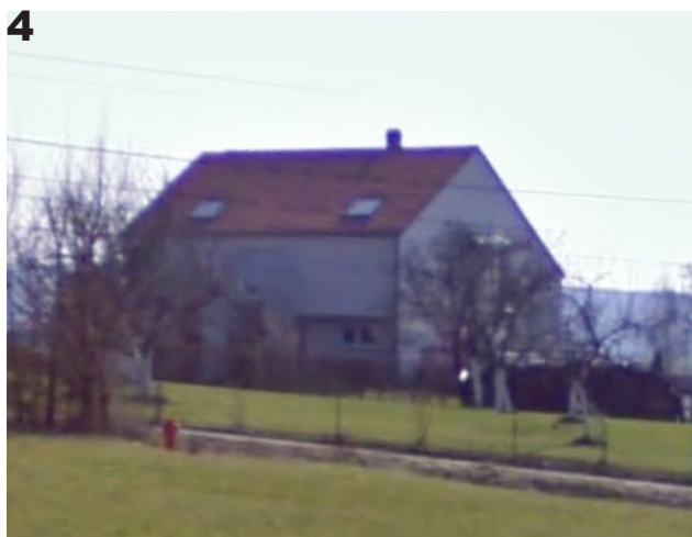
Maison individuelle de type du R+2 de faîtage parallèle à la voirie
