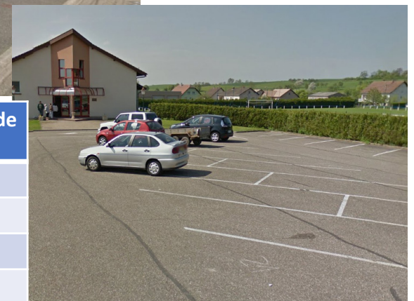
Parking excentré au niveau du stade
