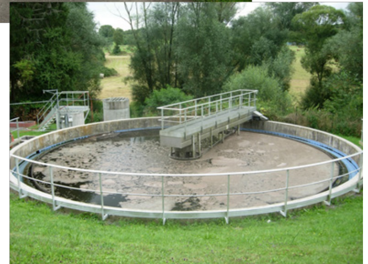
Station d'épuration de Rohrbach-Lès-Bitche
