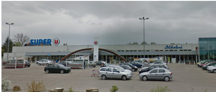
SUPER U de Rohrbach-lès-Bitche
