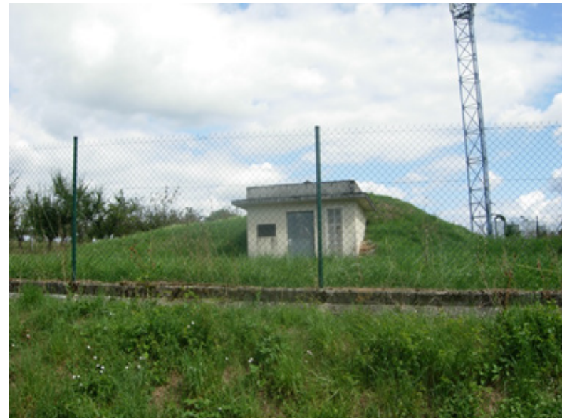
Réservoir d'eau potable sur la commune d'Achen
