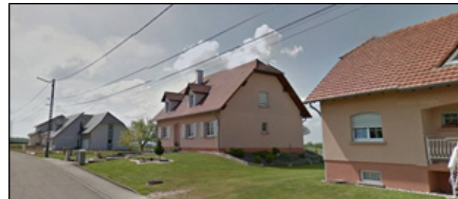
Photographie de maisons individuelles en extension de Rohrbach-lès-Bitche
