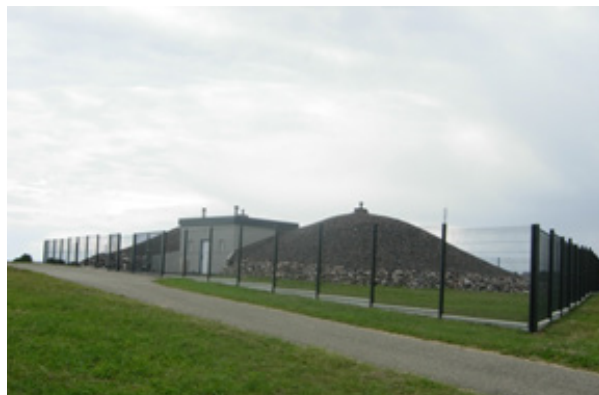
Réservoir d'eau potable de Rohrbach-lès-Bitche
