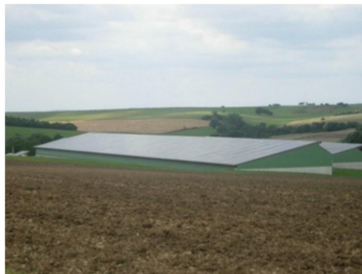
Panneaux solaires sur les toits des bâtiments agricoles de l'EARL Kirsh
