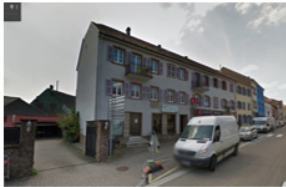
Rohrbach : Centre ancien
