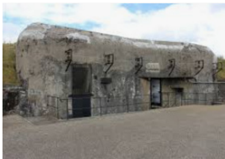
Fort Casso à Rohrbach-lès-Bitche
