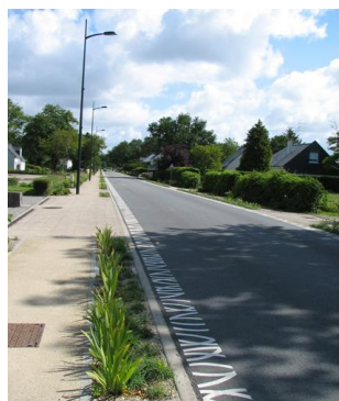
Exemple de requalification possible (CAUE 44)
