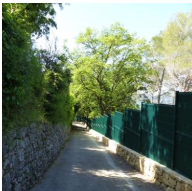
Panneaux rigides préfabriqués à interdire
