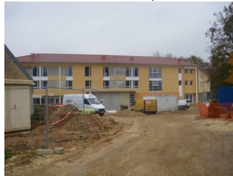
L'EHPAD de St-Amand-en-Puisaye en construction
