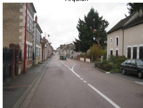
Réaménagement de la rue principale à Arquian
