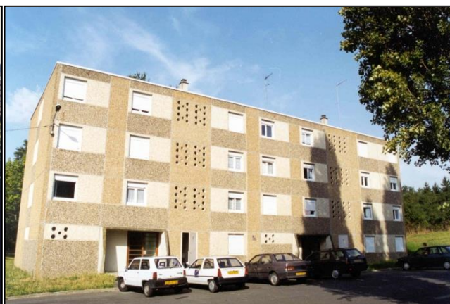
Logements sociaux de Logivie
