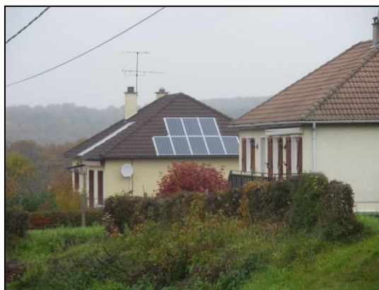
Panneaux solaires sur une maison ancienne à Saint Amand-en-Puisaye
