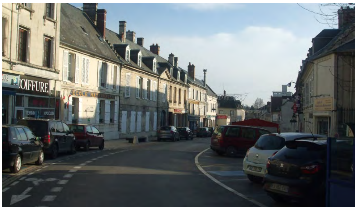
Rue du Général Mangin
