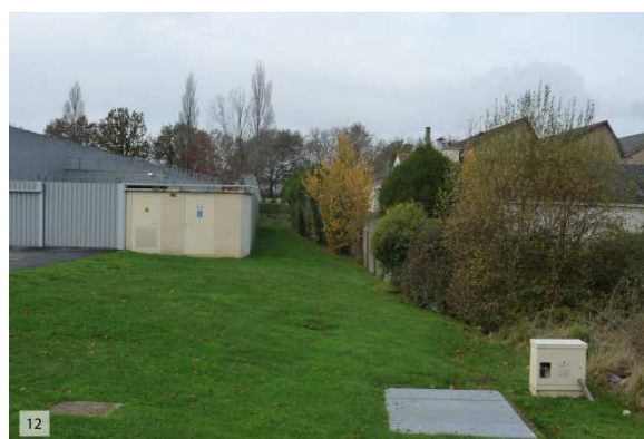
12- Fonds de parcelle derrière le supermarché E.Leclerc
