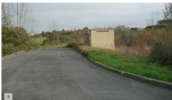
9- Fin de la voirie (nord) et transformateur
