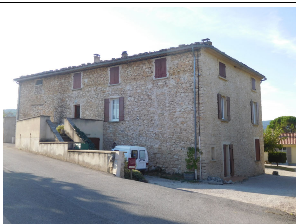
O. Bâtisse, AC 119 Saint Estève
