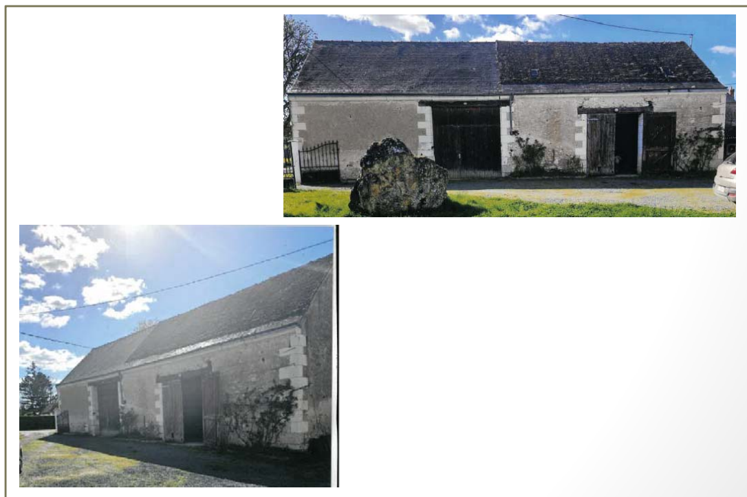
Photo(s) du bâti
