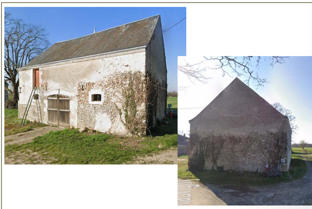
Photo(s) du bâti
