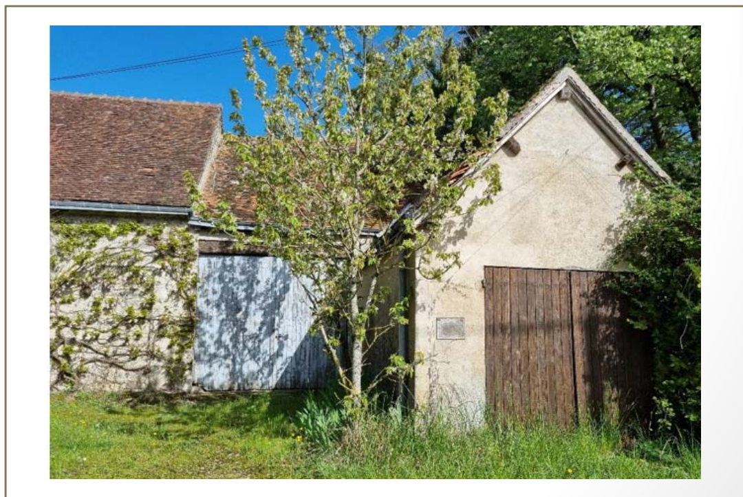
Photo(s) du bâti
