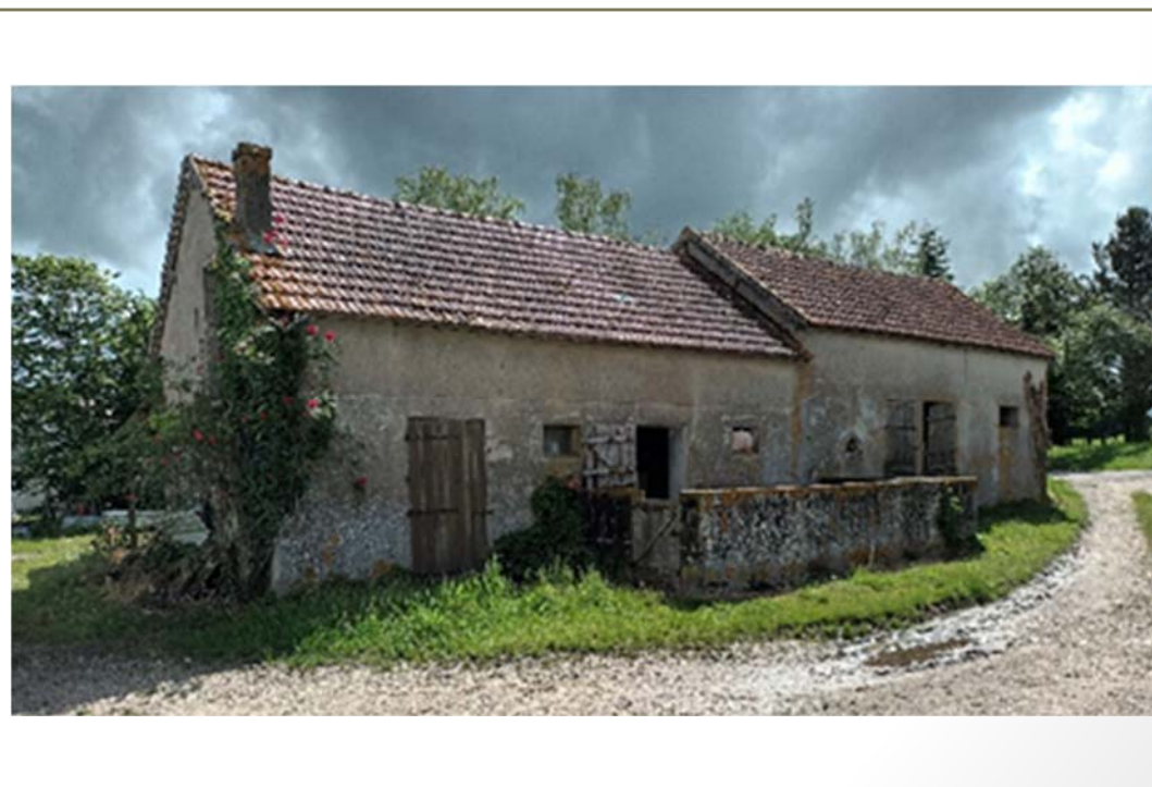
Photo(s) du bâti
