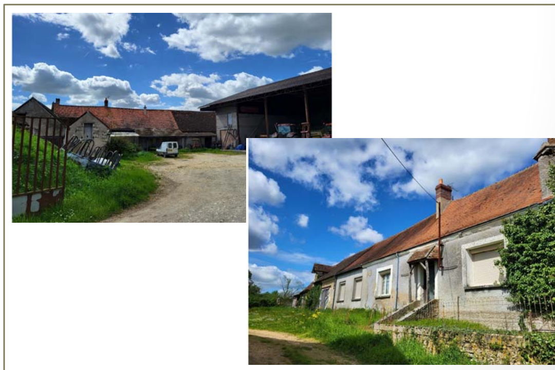
Photo(s) du bâti
