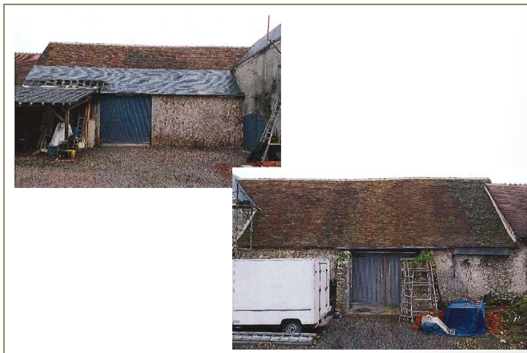
Photo(s) du bâti
