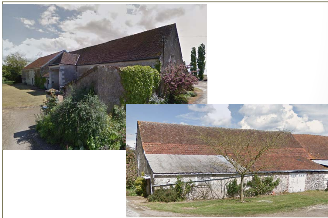
Photo(s) du bâti
