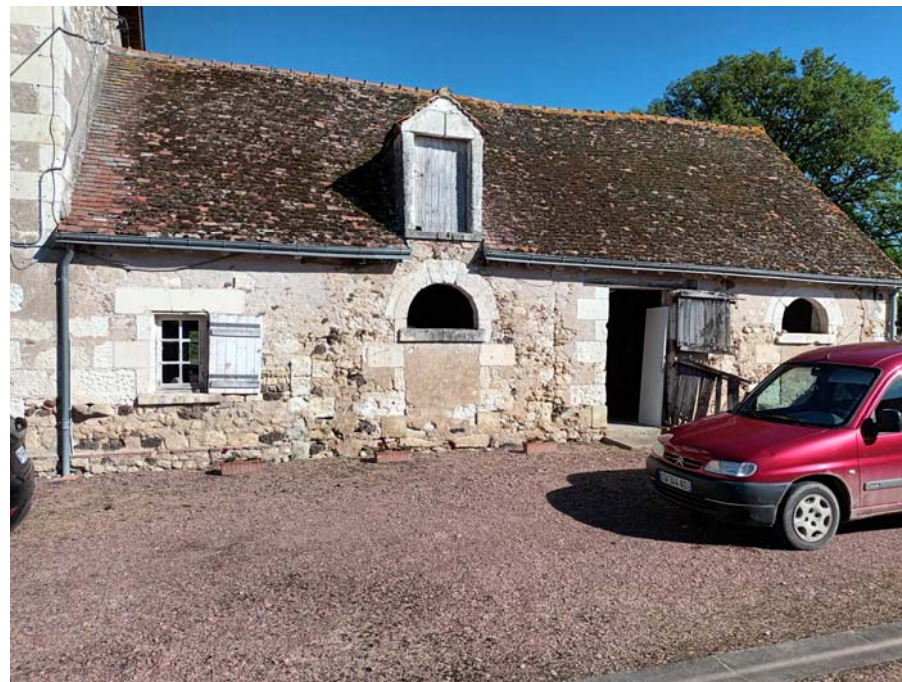
Photo(s) du bâti
