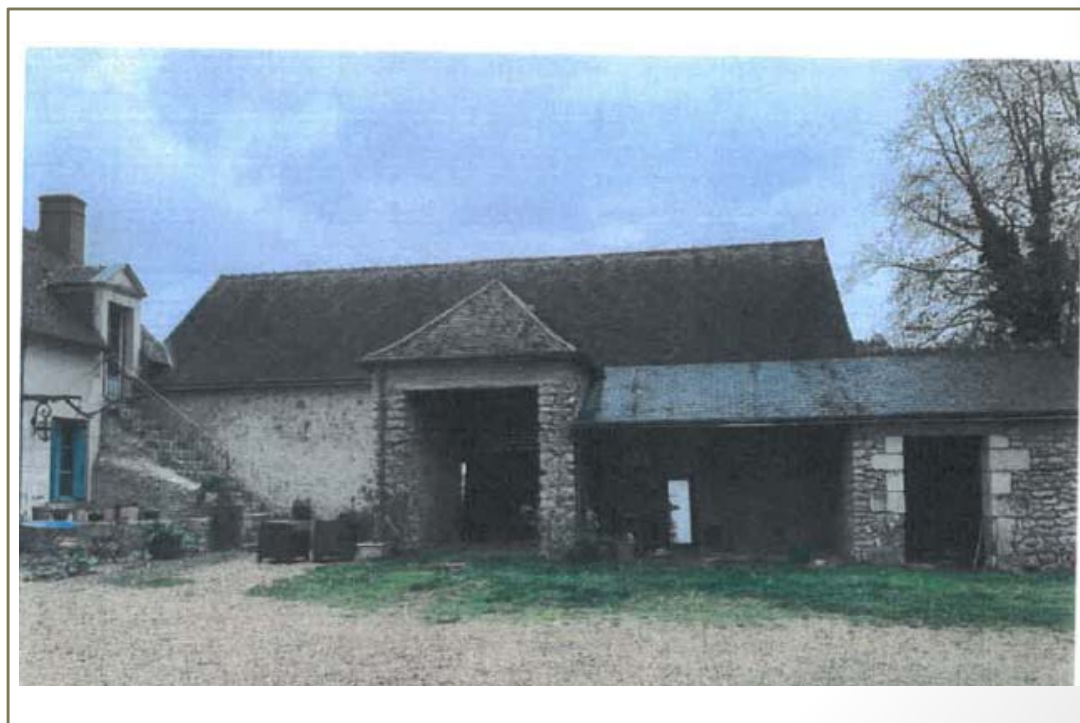
Photo(s) du bâti
