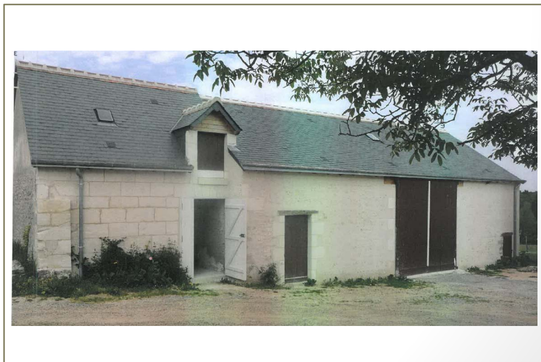
Photo(s) du bâti
