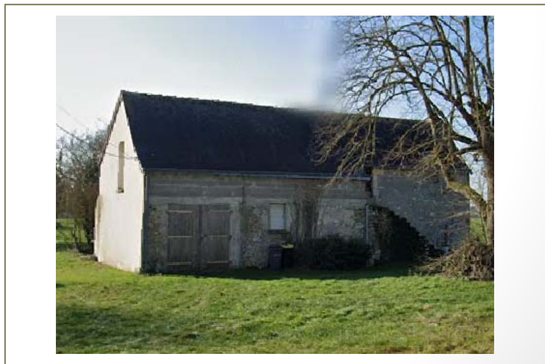
Photo(s) du bâti
