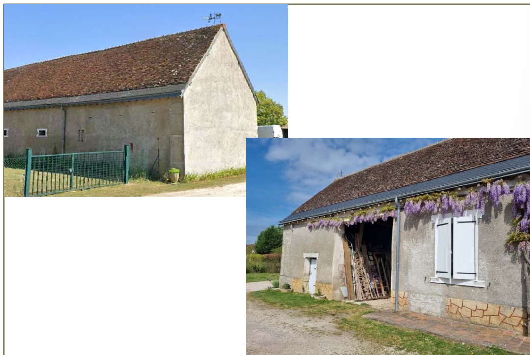
Photo(s) du bâti
