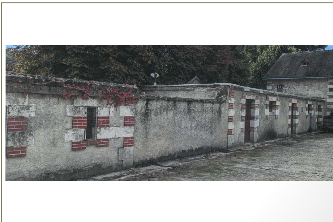
Photo(s) du bâti
