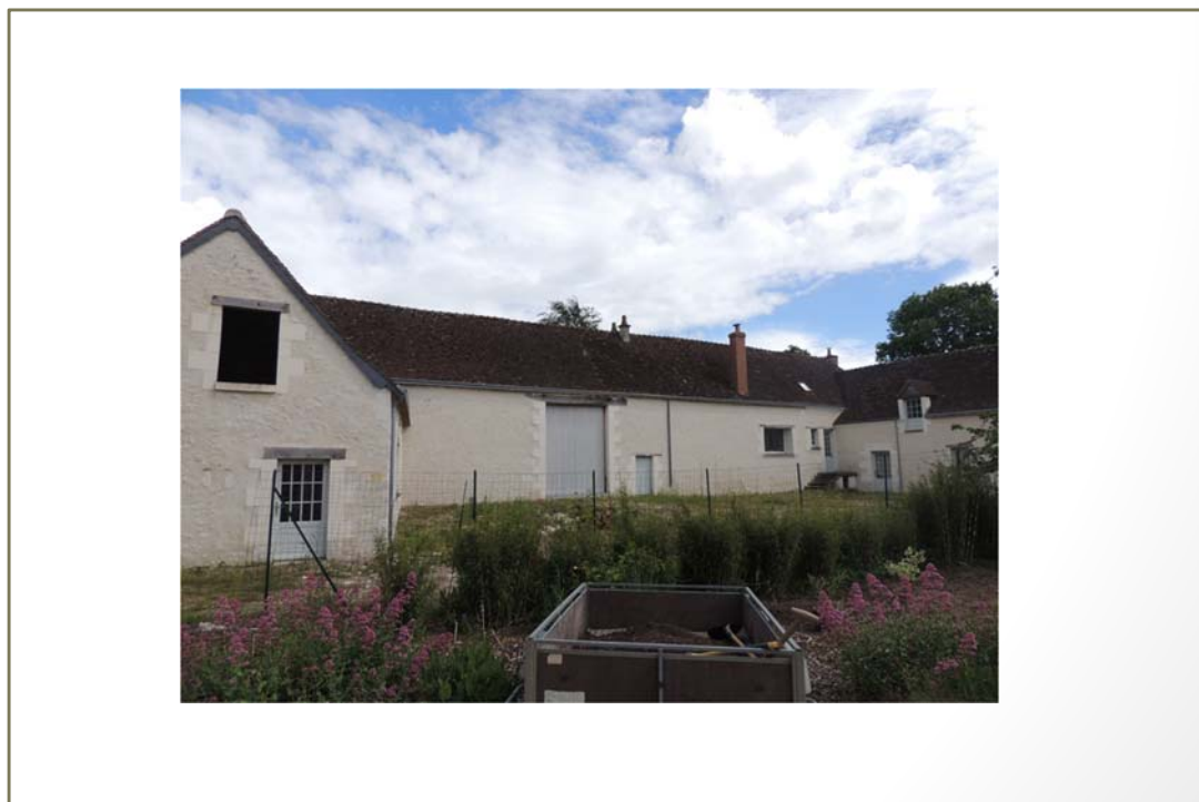
Photo(s) du bâti
