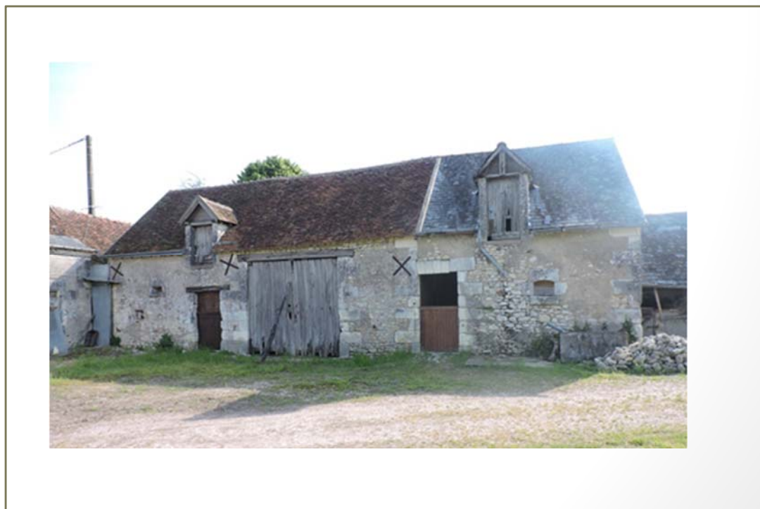
Photo(s) du bâti
