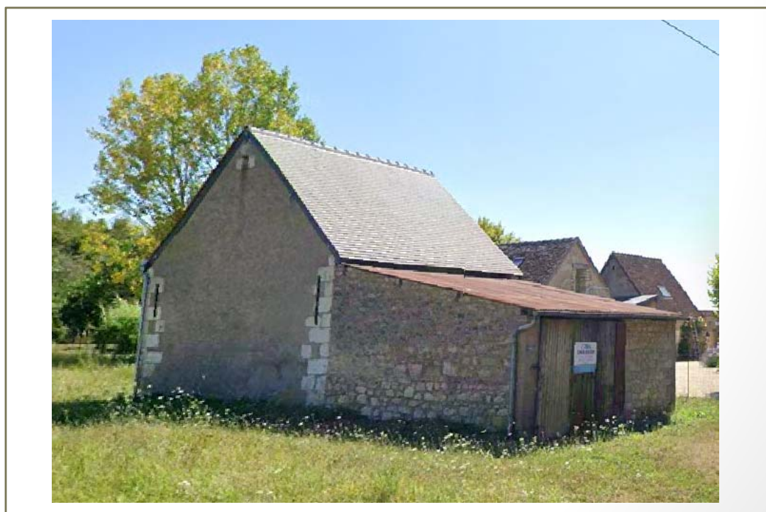
Photo(s) du bâti
