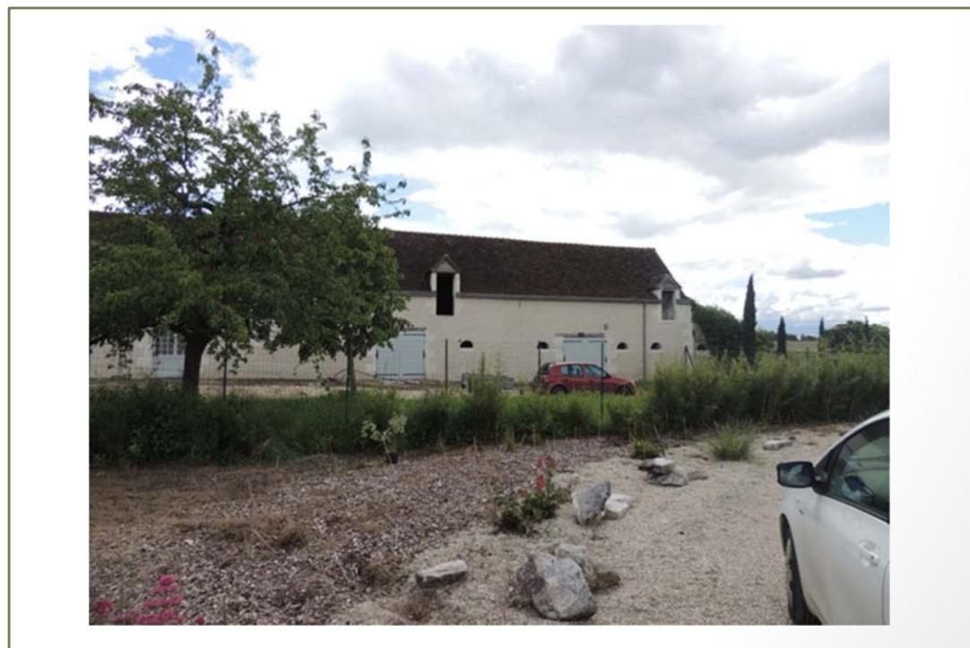
Photo(s) du bâti
