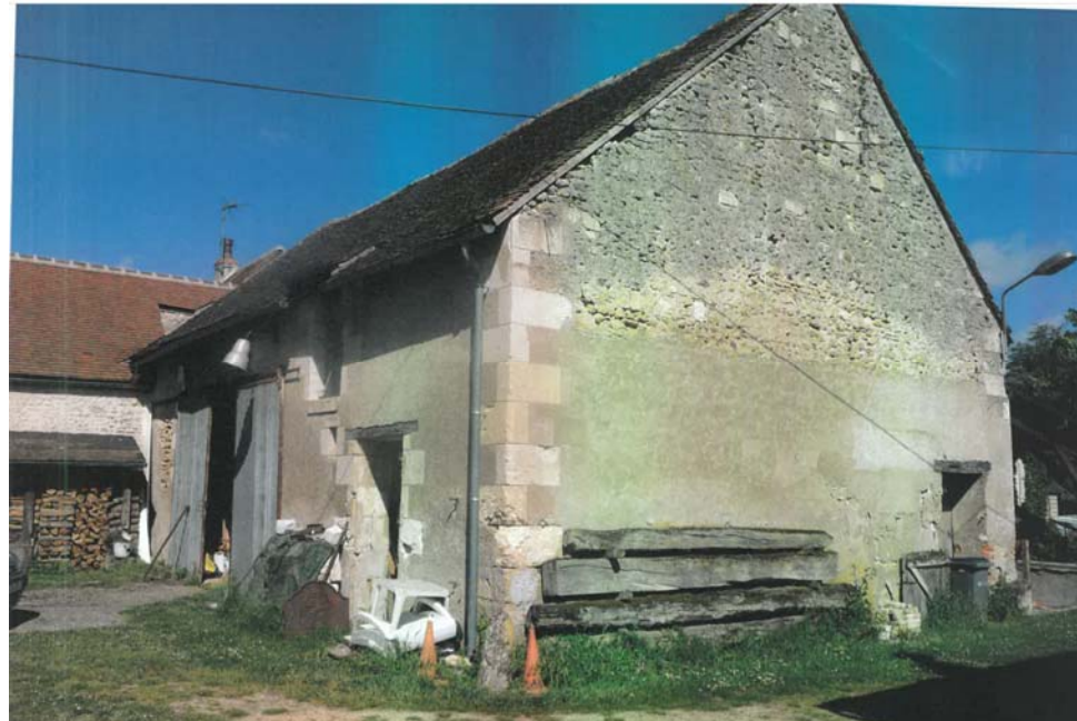
Photo(s) du bâti
