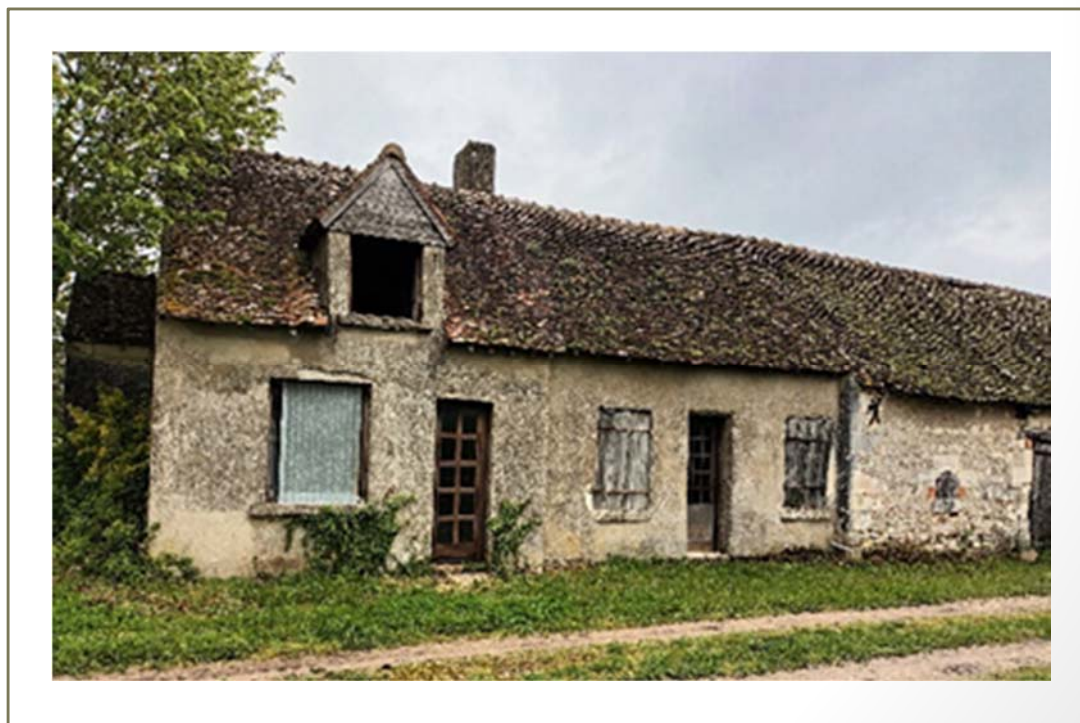
Photo(s) du bâti
