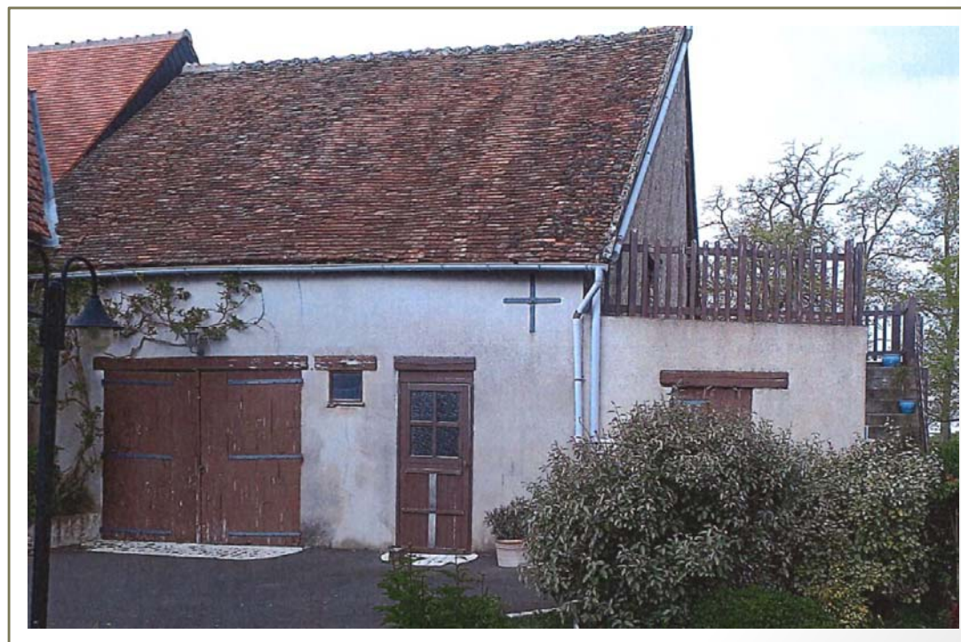
Photo(s) du bâti
