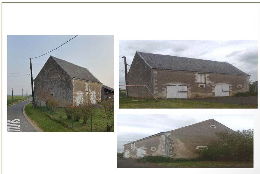
Photo(s) du bâti
