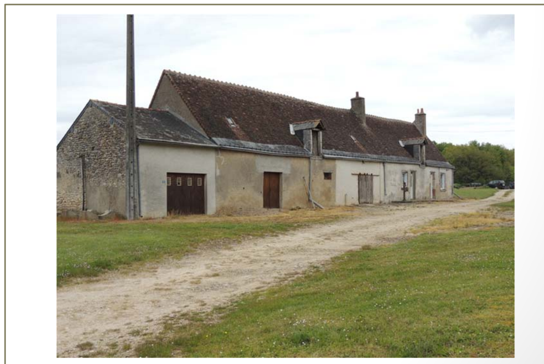
Photo(s) du bâti
