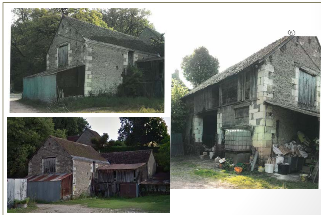
Photo(s) du bâti
