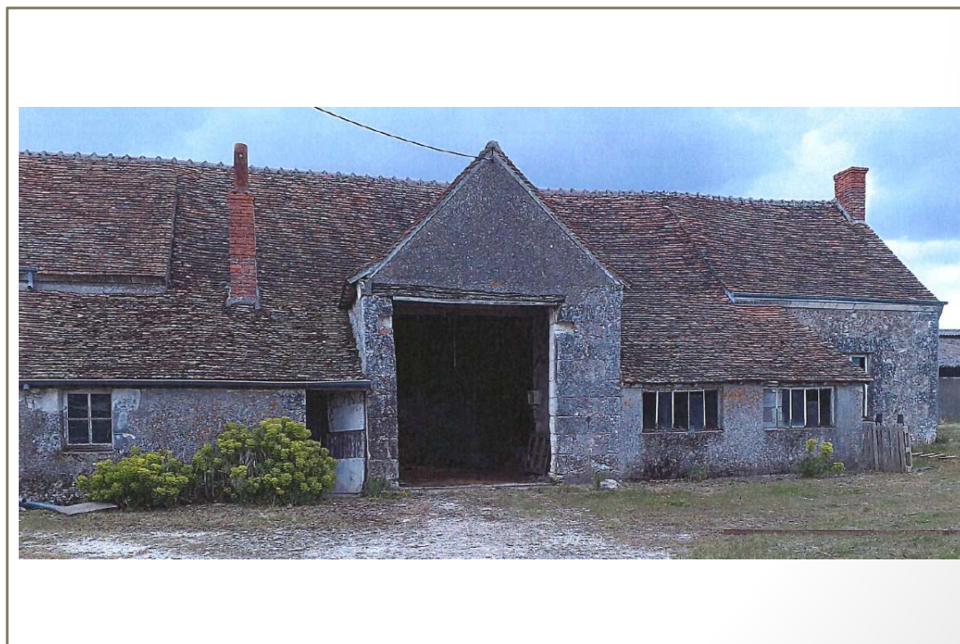
Photo(s) du bâti
