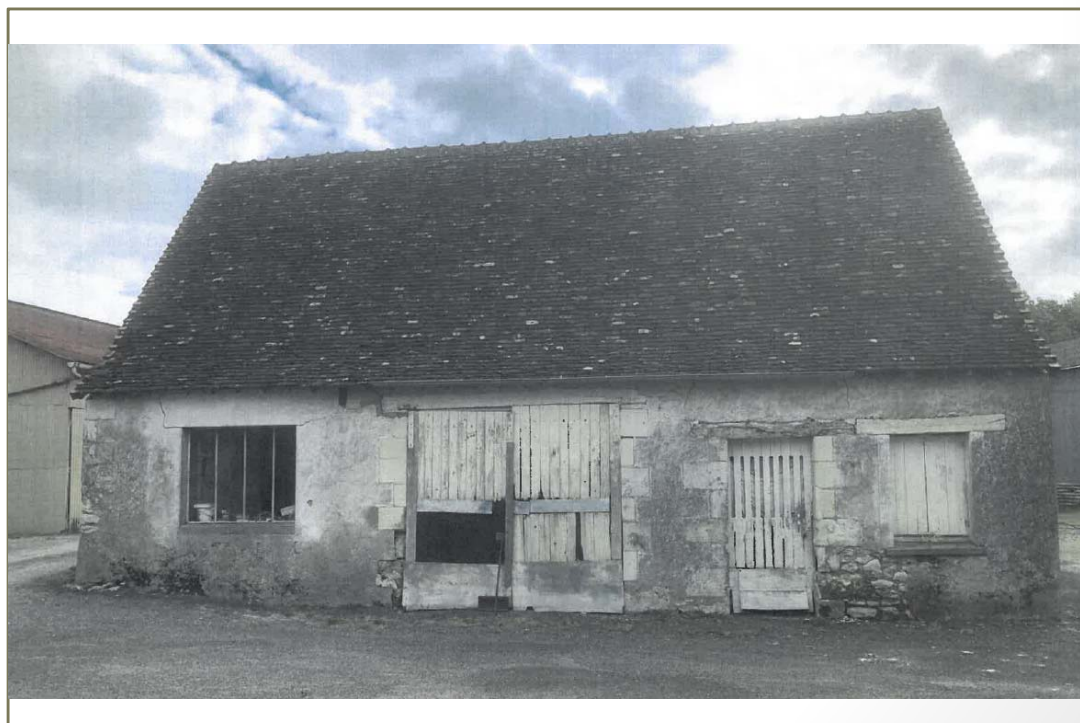
Photo(s) du bâti
