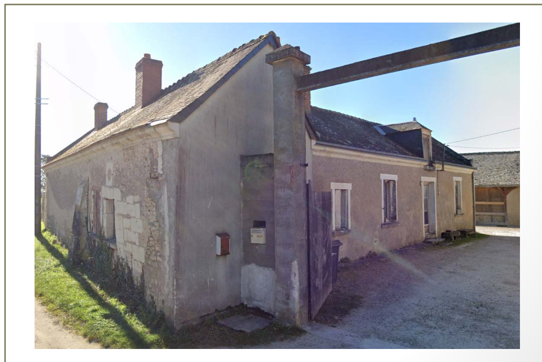
Photo(s) du bâti
