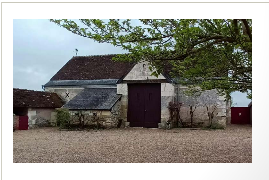
Photo(s) du bâti
