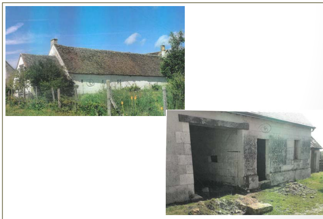
Photo(s) du bâti
