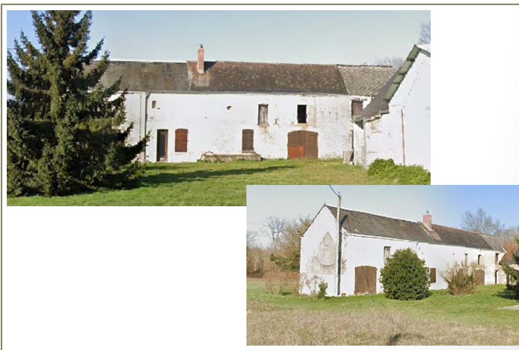
Photo(s) du bâti
