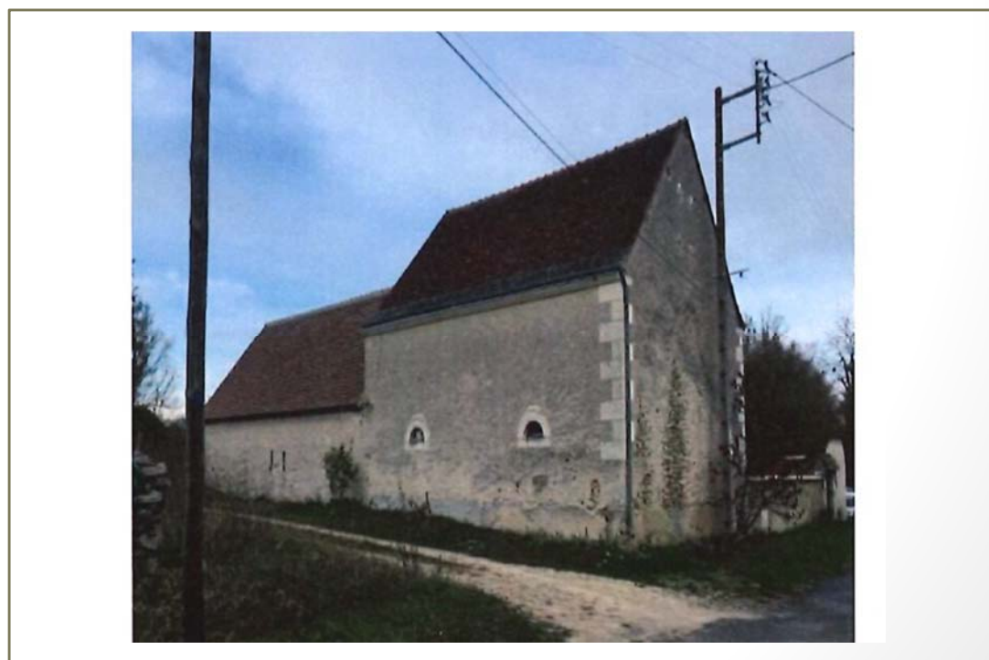
Photo(s) du bâti
