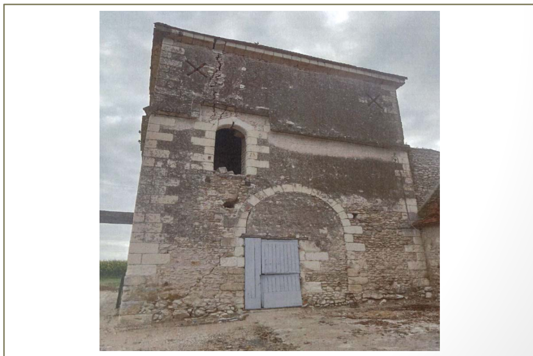
Photo(s) du bâti
