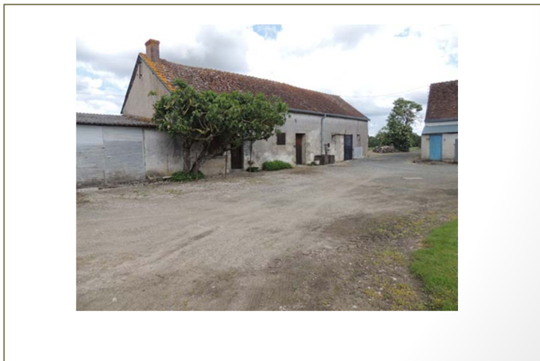
Photo(s) du bâti
