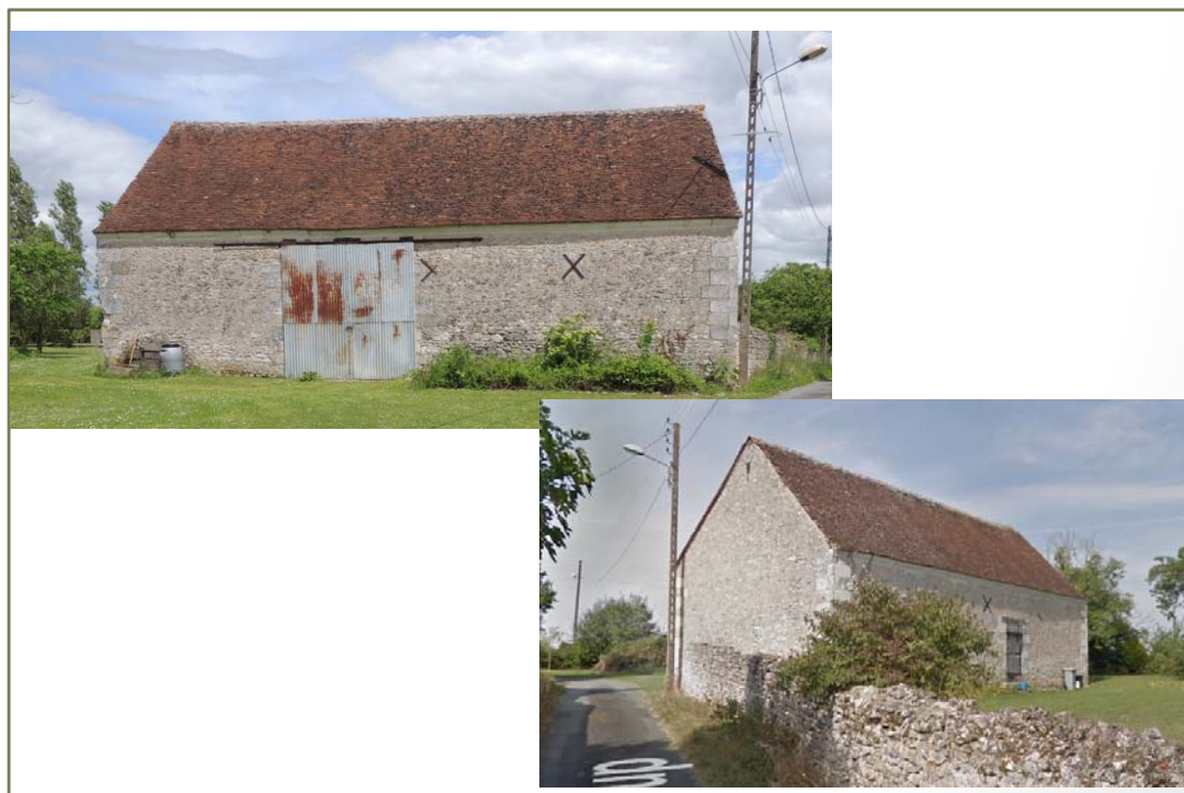
Photo(s) du bâti
