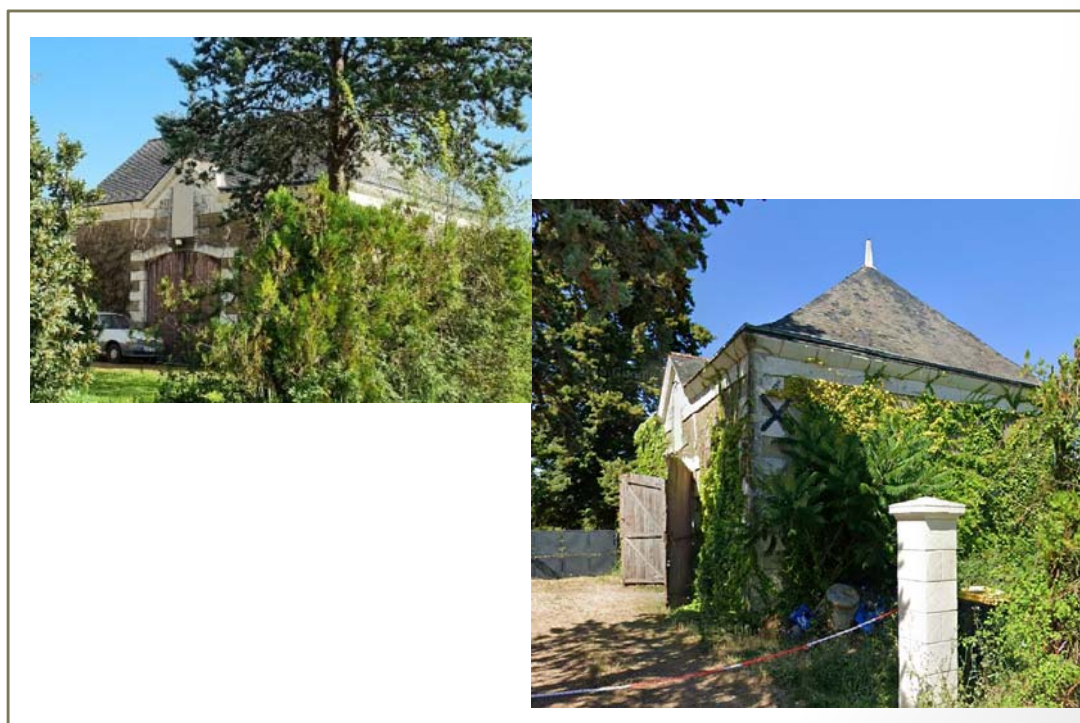
Photo(s) du bâti
