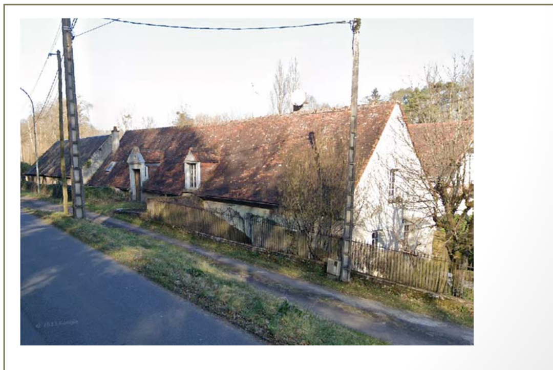
Photo(s) du bâti
