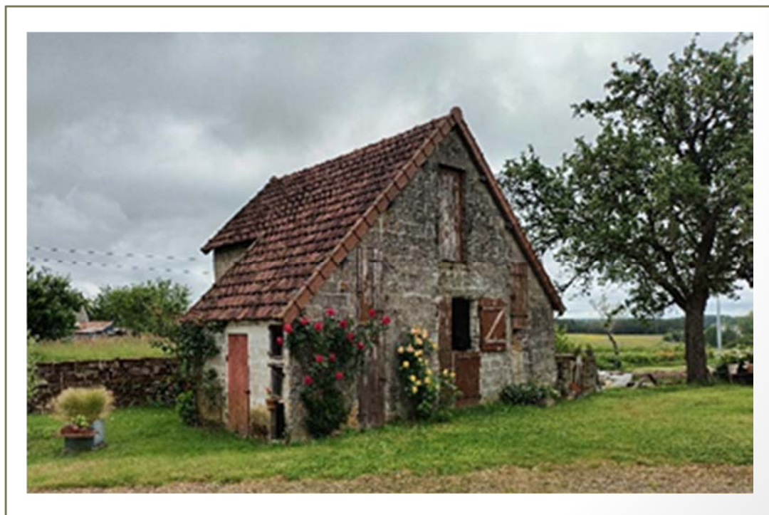
Photo(s) du bâti
