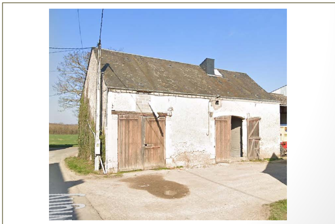
Photo(s) du bâti
