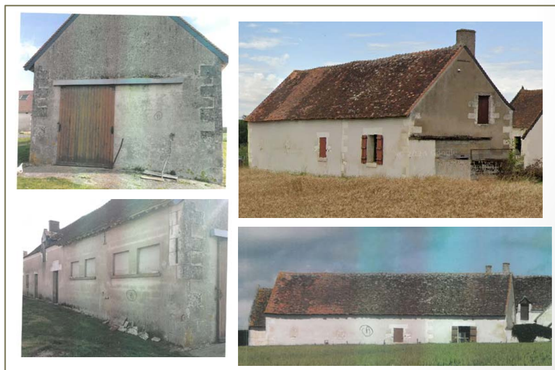
Photo(s) du bâti
