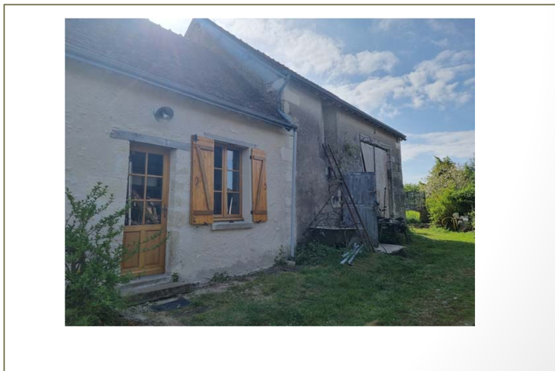
Photo(s) du bâti
