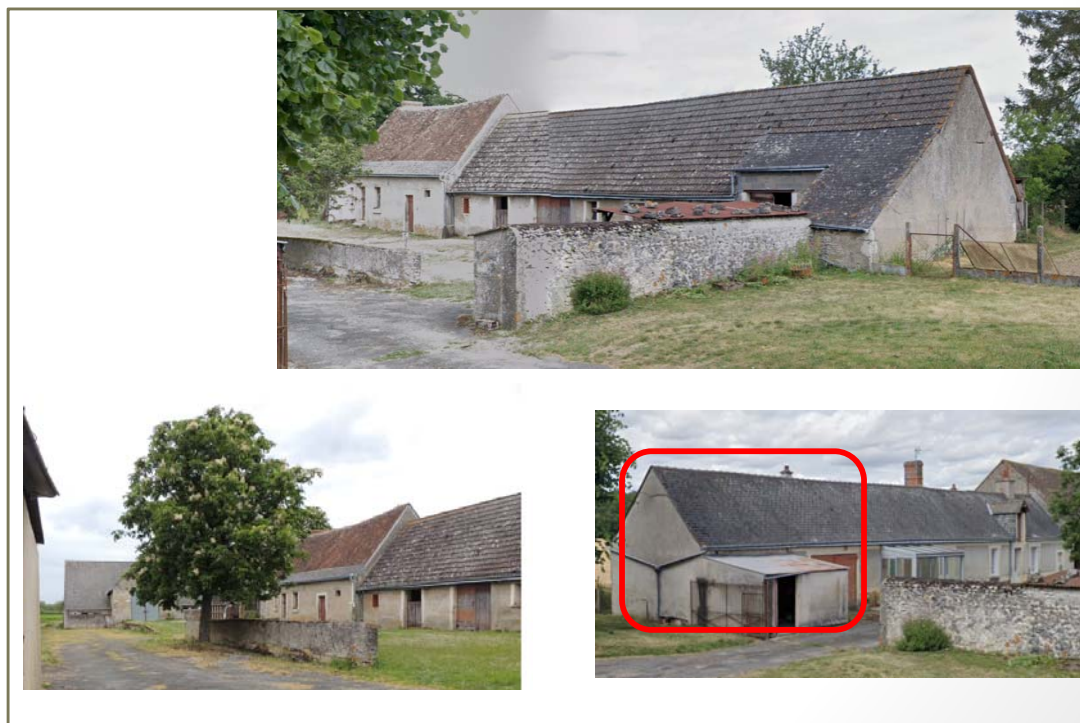
Photo(s) du bâti
