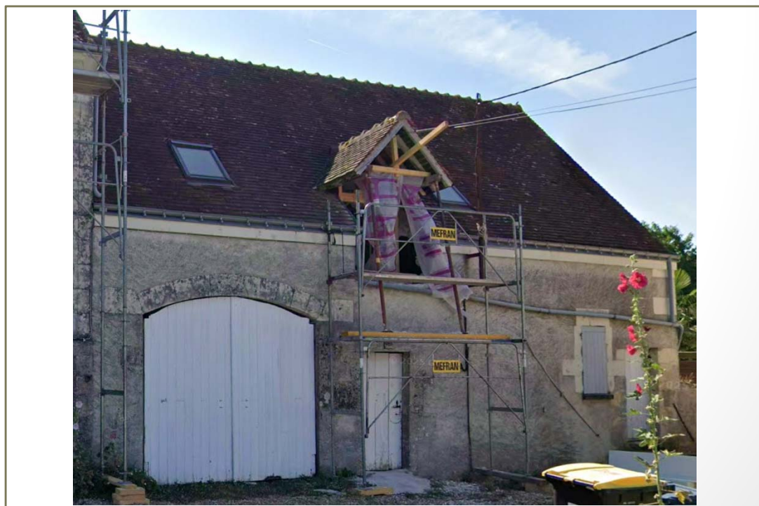
Photo(s) du bâti
