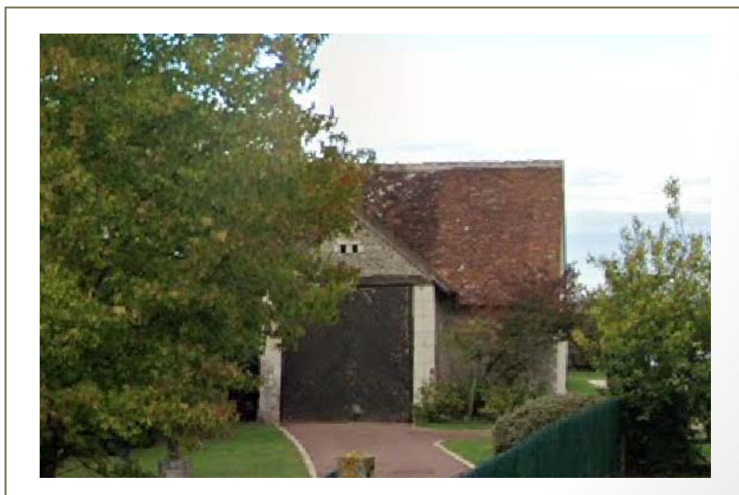
Photo(s) du bâti
