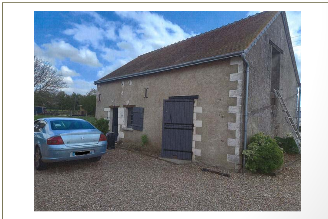
Photo(s) du bâti
