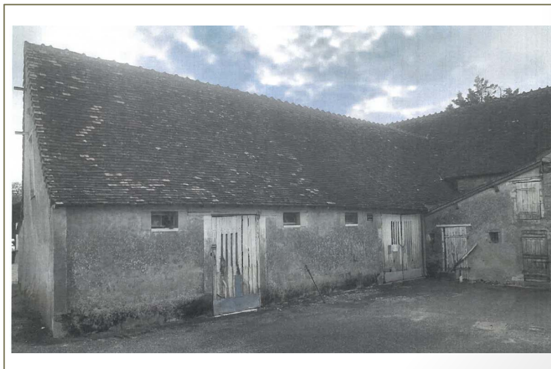
Photo(s) du bâti
