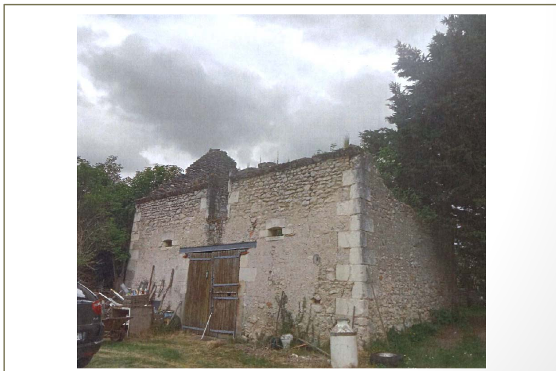
Photo(s) du bâti
