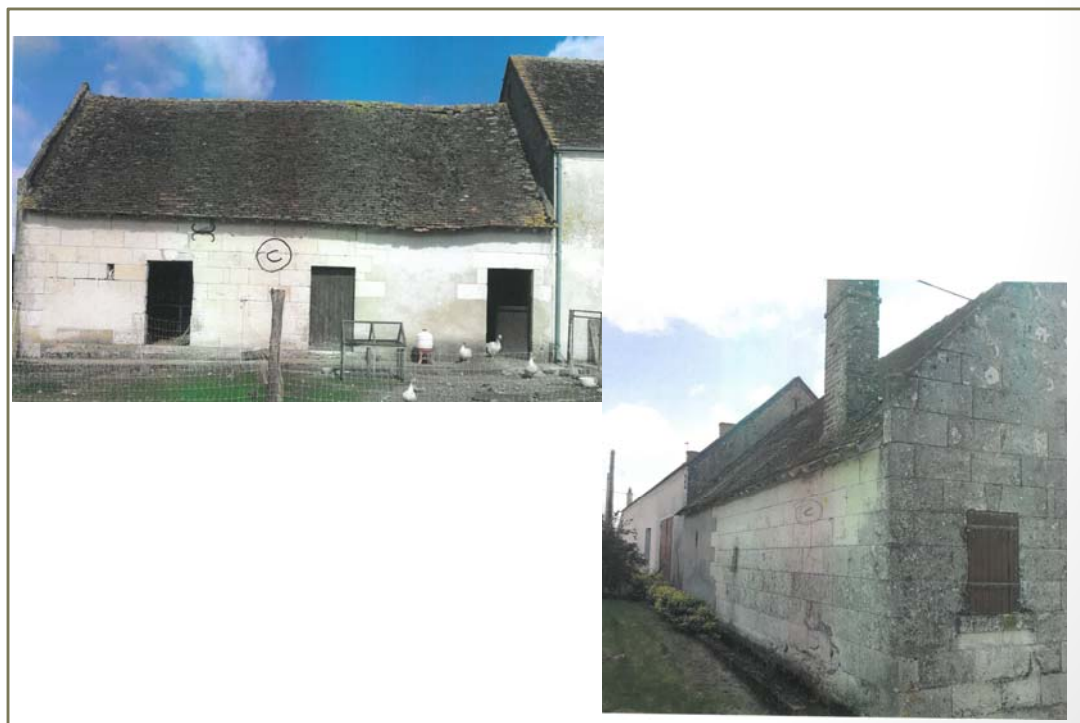
Photo(s) du bâti
