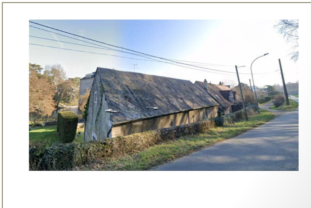
Photo(s) du bâti
