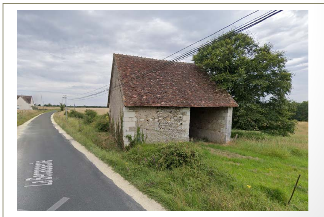
Photo(s) du bâti
