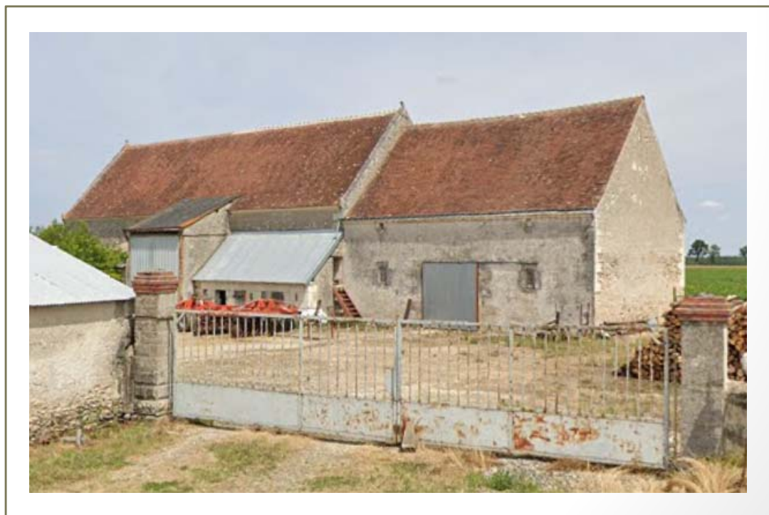
Photo(s) du bâti
