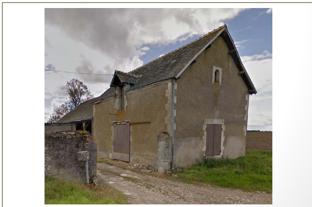
Photo(s) du bâti
