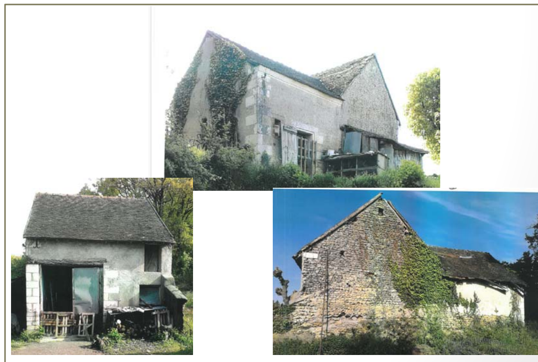
Photo(s) du bâti
