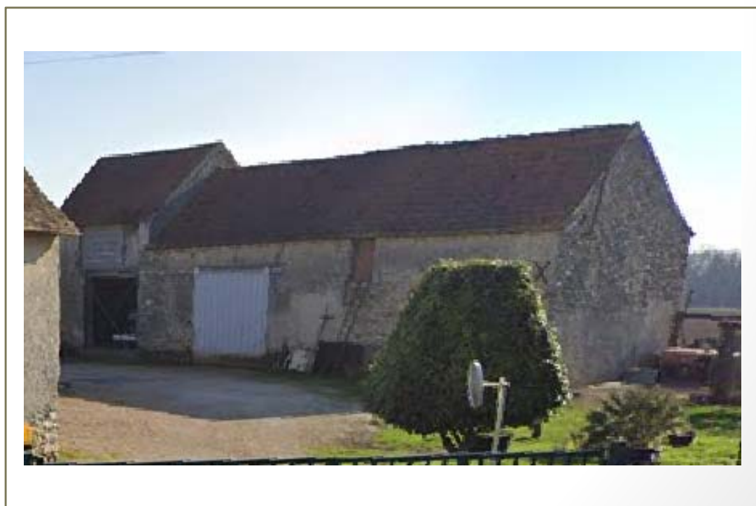
Photo(s) du bâti
