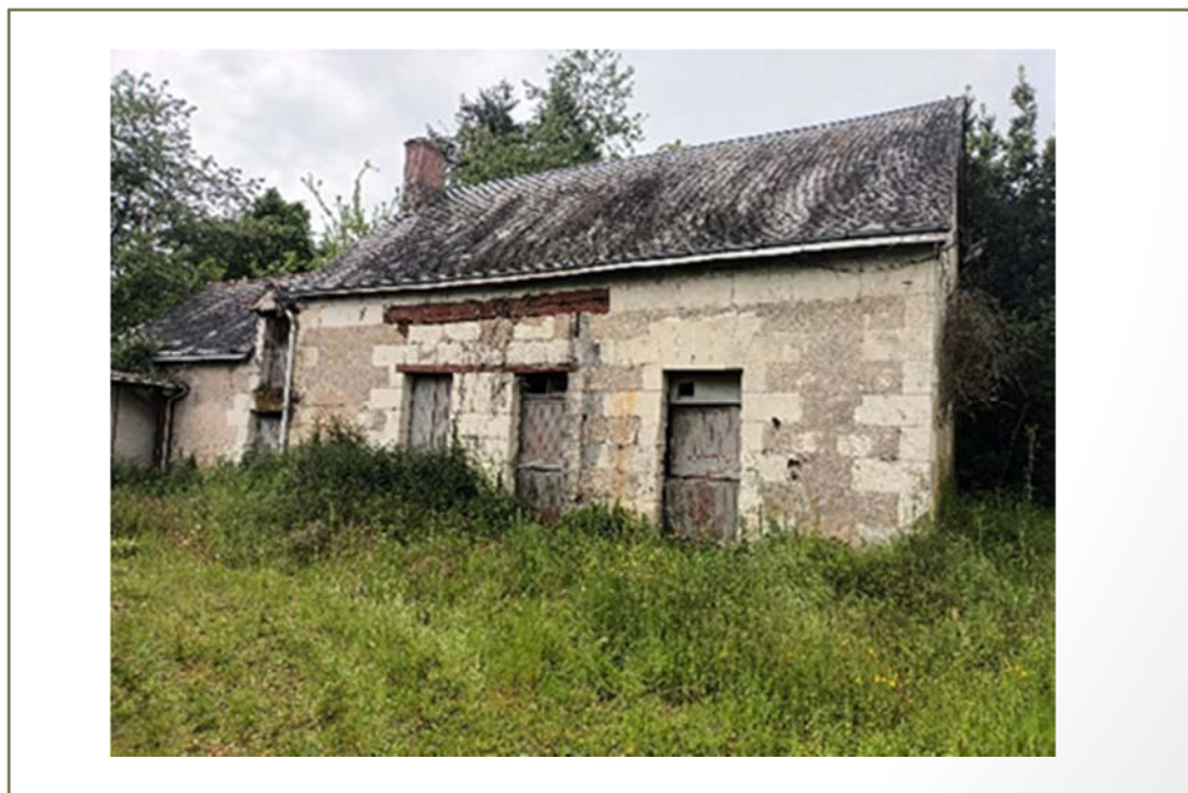
Photo(s) du bâti
