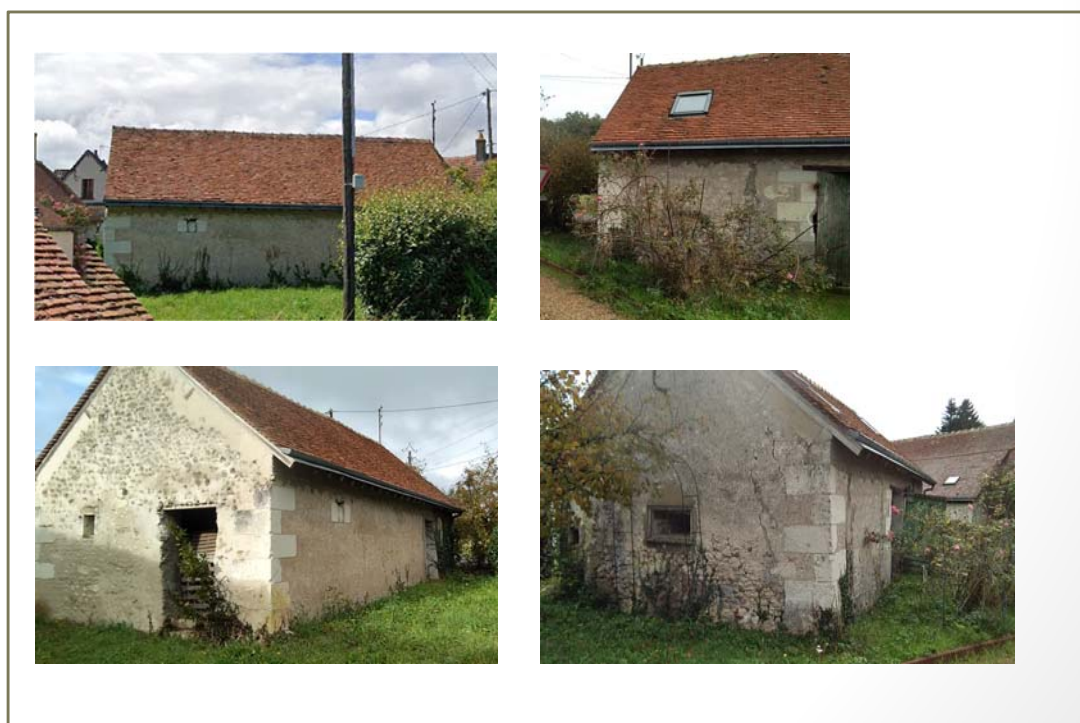
Photo(s) du bâti
