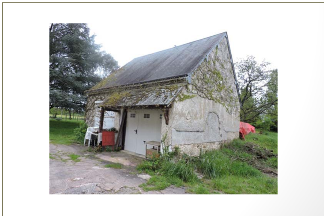
Photo(s) du bâti
