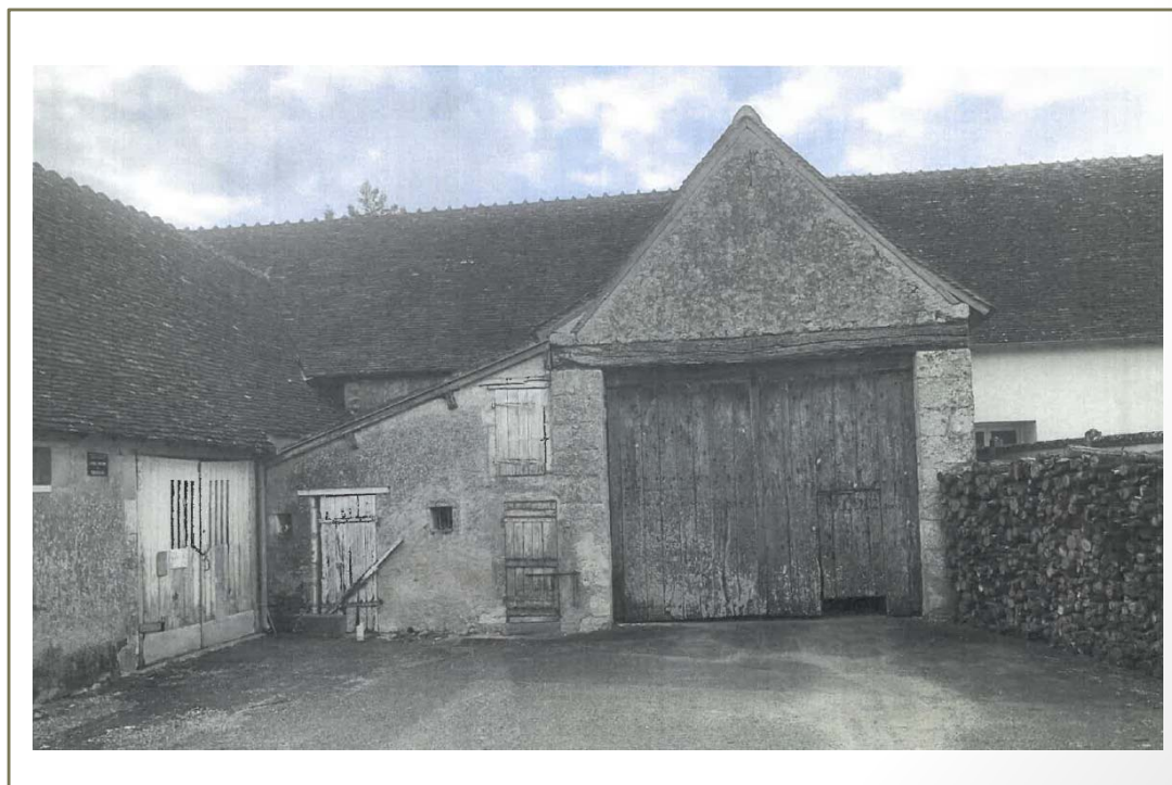
Photo(s) du bâti
