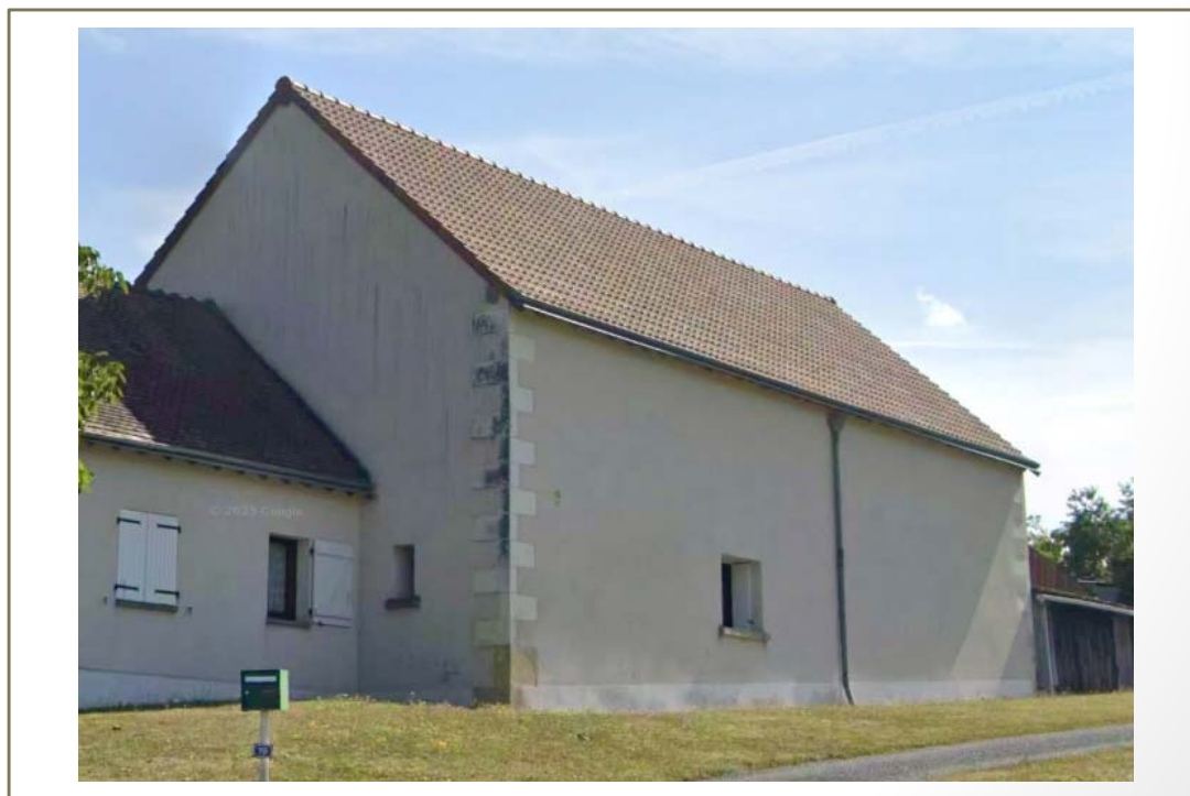
Photo(s) du bâti
