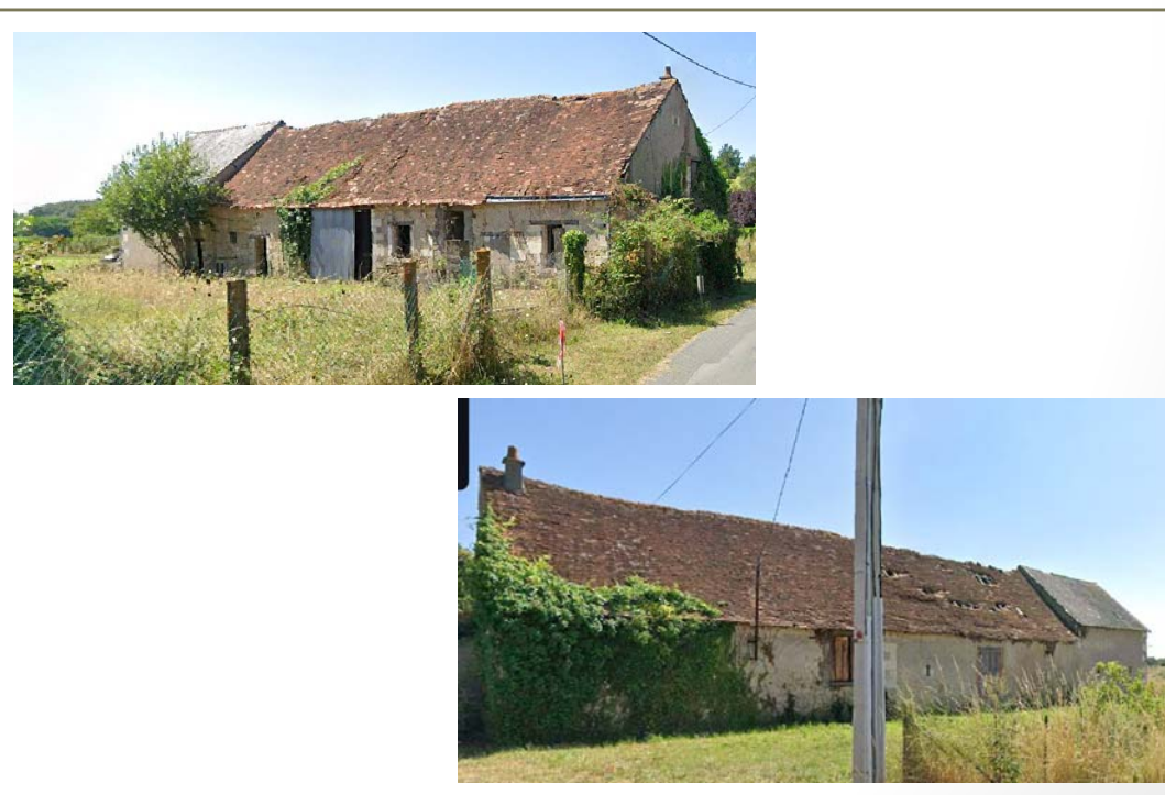
Photo(s) du bâti
