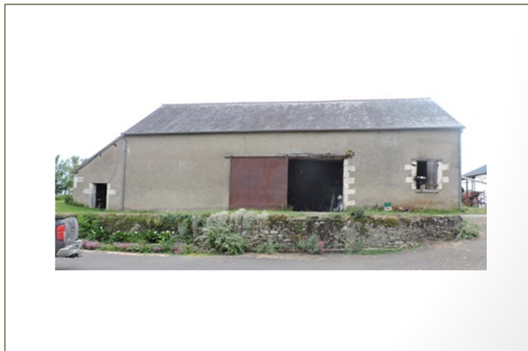
Photo(s) du bâti
