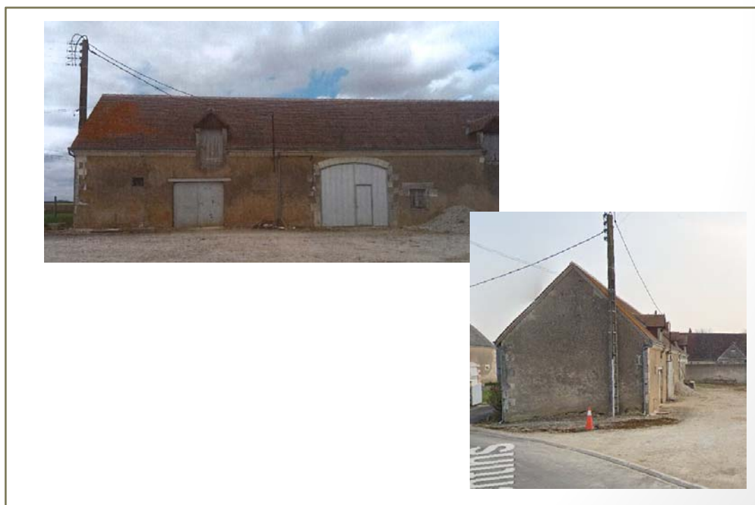
Photo(s) du bâti
