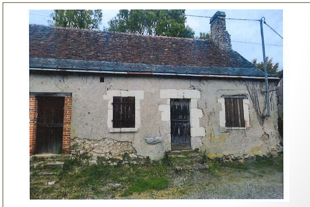
Photo(s) du bâti
