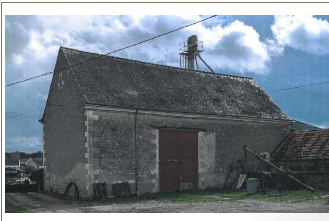
Photo(s) du bâti
