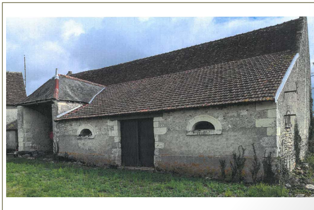
Photo(s) du bâti
