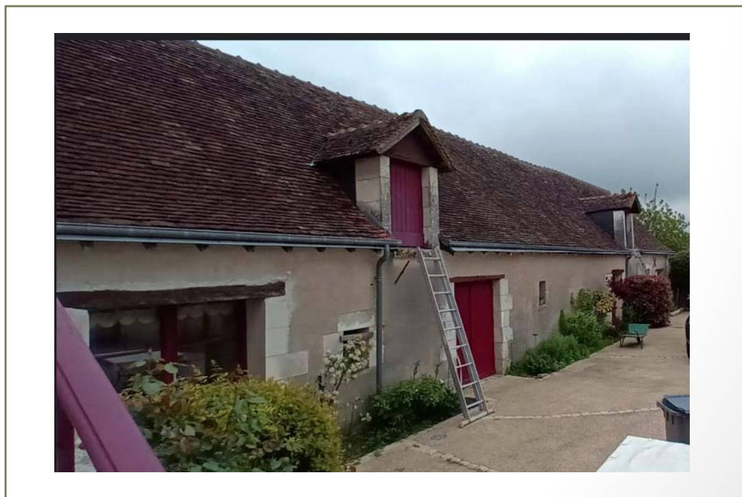
Photo(s) du bâti
