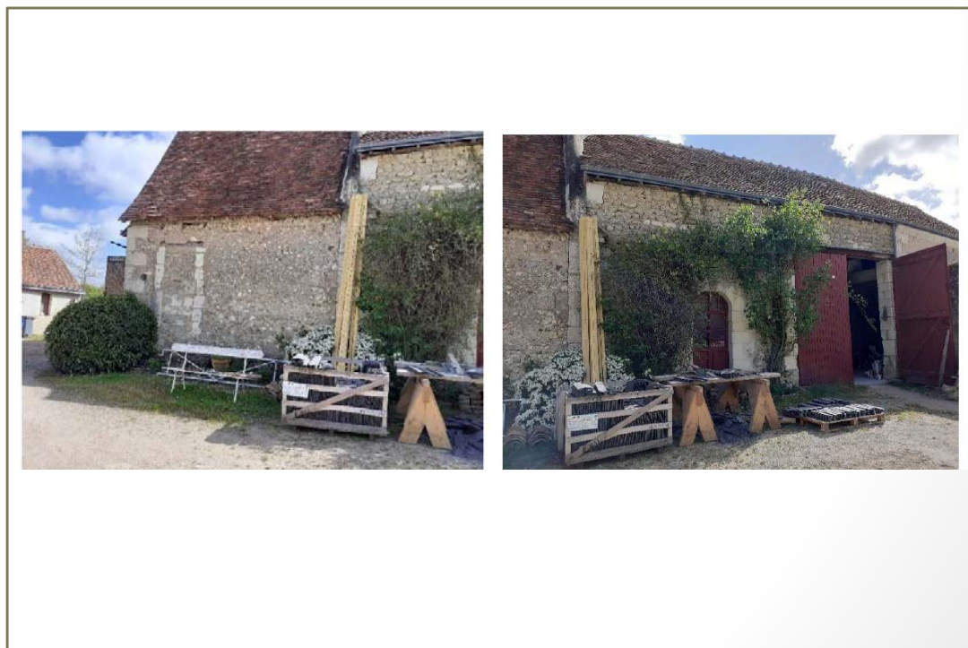
Photo(s) du bâti
