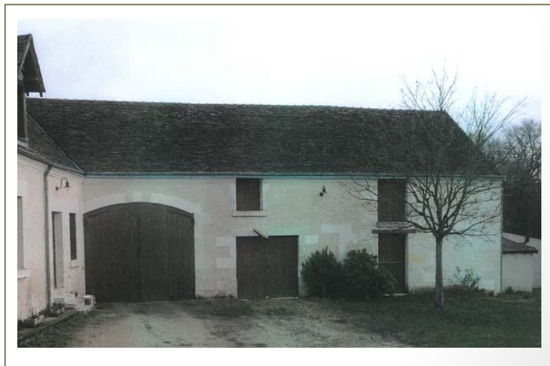
Photo(s) du bâti
