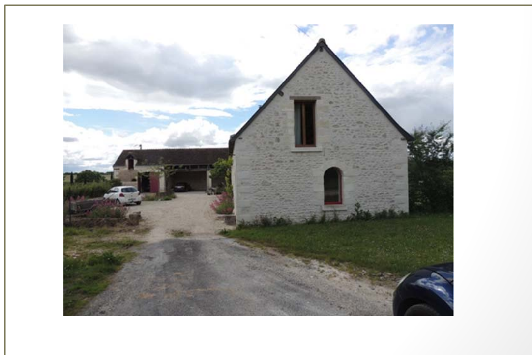
Photo(s) du bâti
