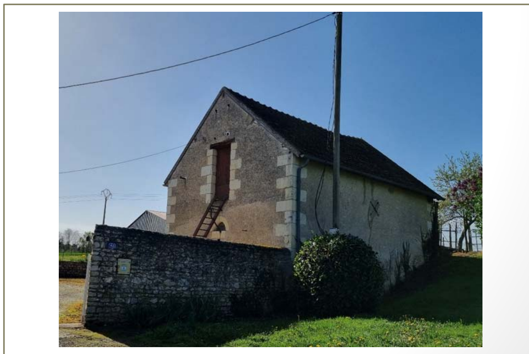
Photo(s) du bâti
