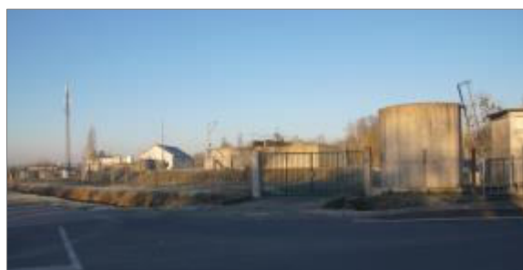
Stations d'épuration de Bléré (source :ADEV environnement)
