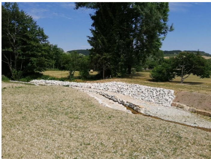
Restauration du lit du cours d'eau à Fronville – (source : Communauté de Communes du Bassin de Joinville-en-Champagne)
