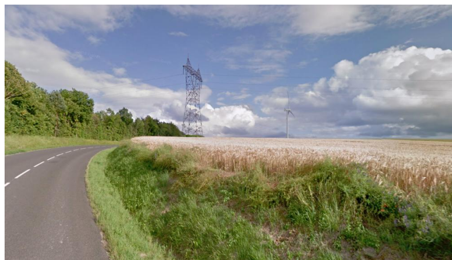
Lignes électriques traversant le territoire d'ouest en est – Flammerécourt (source : Google StreetView)
