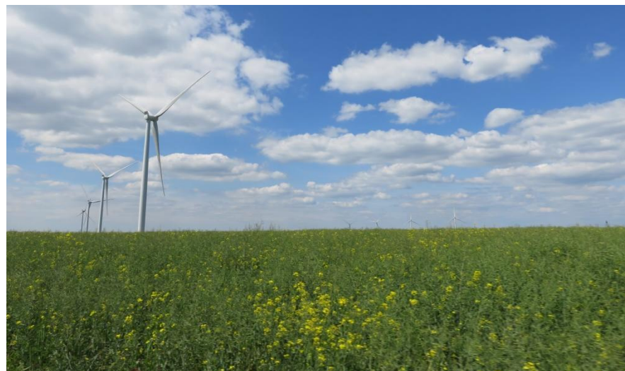
Parc éolien présentant un risque de collision avec l'avifaune et les chiroptères – Doulevant-le-Château (source : Even conseil)
