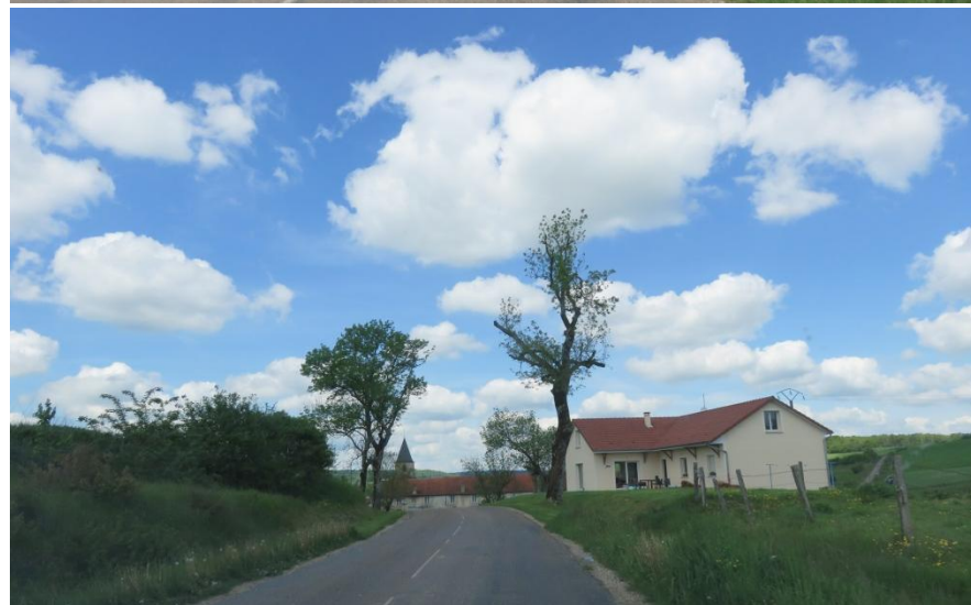
Des entrées de ville altérées par la présence de bâtis peu intégrés, à améliorer – Nomécourt et Bettoncourt-le-Haut (source : Even conseil)
