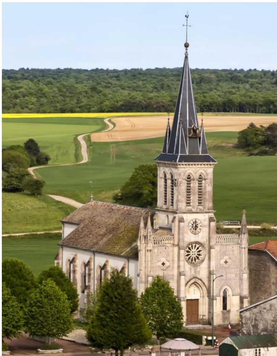
L'église de Gemisay, élément de repère important dans les paysages (source : CCBJC)
