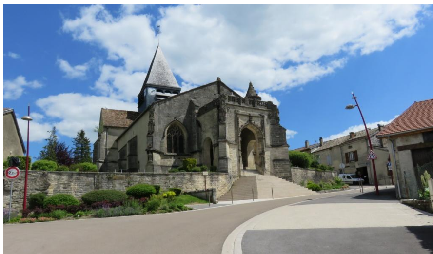
Le traitement paysager des abords de l'église de Poissons (source : Even conseil)
