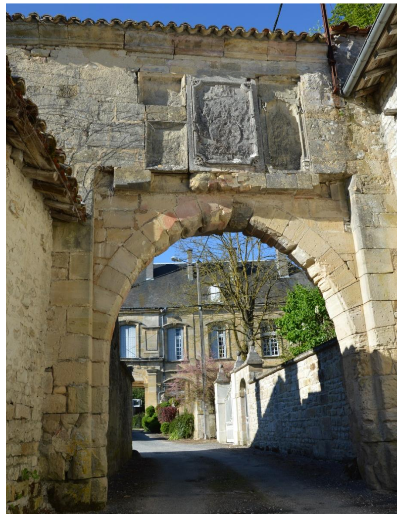
L'abbaye de Saint-Urbain avec sa porte aux allures médiévales, inscrite en tant que monument historique en septembre 1947. Deux façades et la toiture du logis des dames ainsi que la porterie d'entrée datant du 15 ème siècle sont protégés (source : CCBJC)
