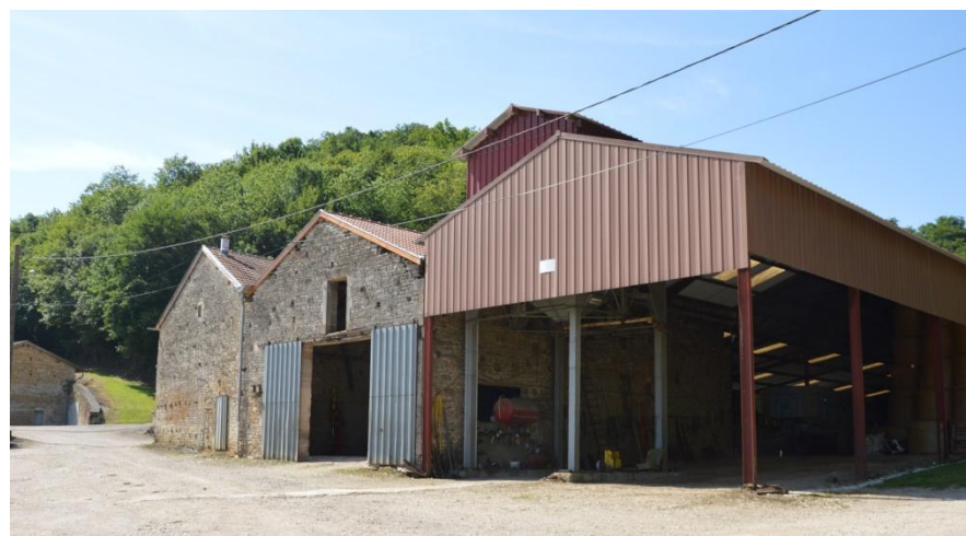
Des hangars de stockage agricole intégrés au bâti ancien de Charmes-en-l'Angle (source : CCBJC)
