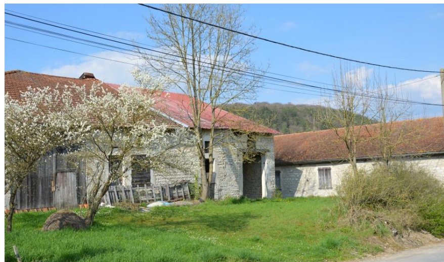
Un corps de ferme ancien valorisé par la végétation à Bouzancourt (source : CCBJC)
