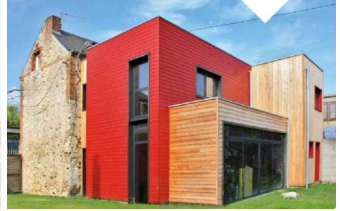
Agrandissement d'une maison de ville respectant la stratégie bioclimatique Atelier 970, Gosselin & Honnet architectes
