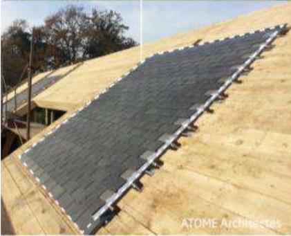
Rénovation d'un bâtiment agricole intégrant des panneaux chauffe-eau solaires à la toiture ardoise (source : ATOME Architecte)
