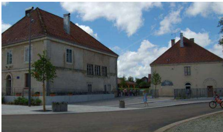
Aménagement d'un carrefour avec le partage de la voirie à Mont-de-Laval (25)
