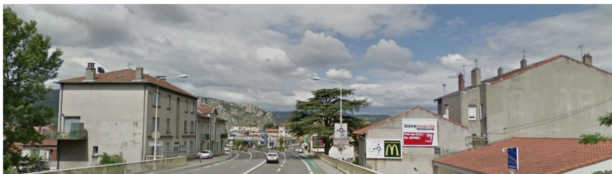
Photo 1. Entrée Est de Guilherand-Granges
