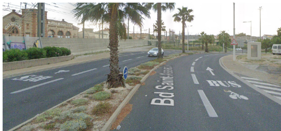
Boulevard Saint-Assiscle (Perpignan) : voie support de partage modal composée d'une voie réservée aux bus et ouverte aux cyclistes de chaque côté, de deux trottoirs et d'un double sens routier (Google Maps, 2022).
