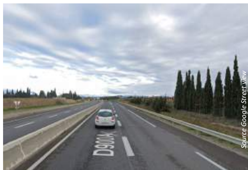
RD900A, alignement de cyprès et talus à valoriser.
