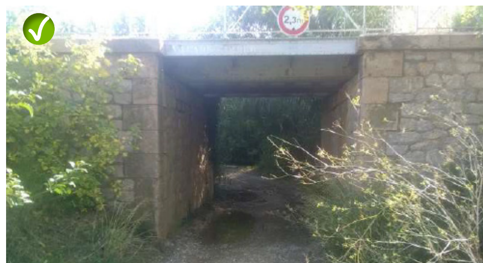
Pont cadre sous TPCF à Rivesaltes. Ecotone®
