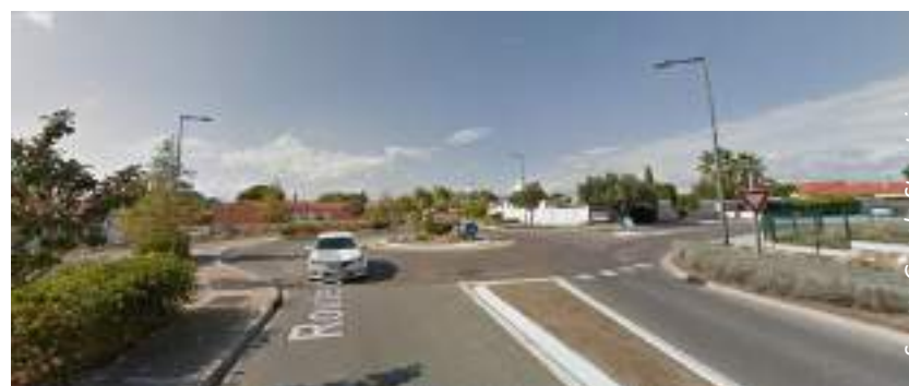
Végétation, éclairage public au niveau du rond-point
