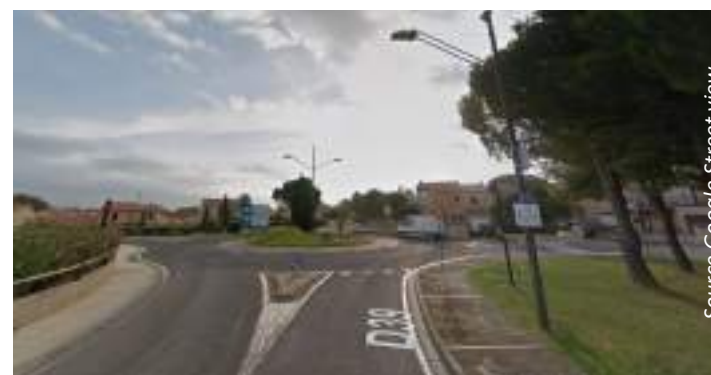
Séquence 2, Intersection aménagée avec signalisation et espaces verts à l'entrée de Pollestres sur la RD39
