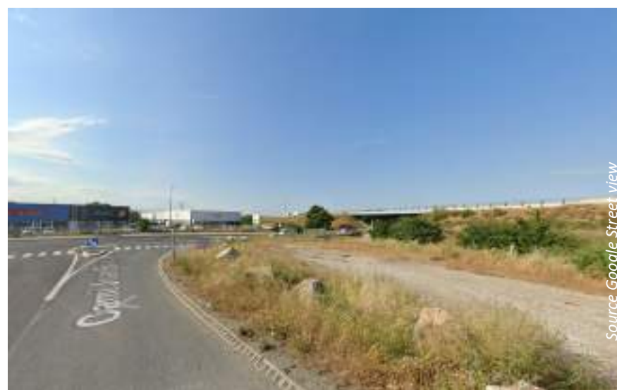
Avenue Panchot, croisement avec le chemin de Joan Biosca, enrochements et délaissés
