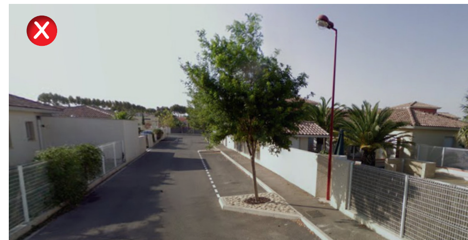
Bordure droite T1 infranchissable, entravant le chemin de l'eau vers le pied d'arbre à Saint-Estève
