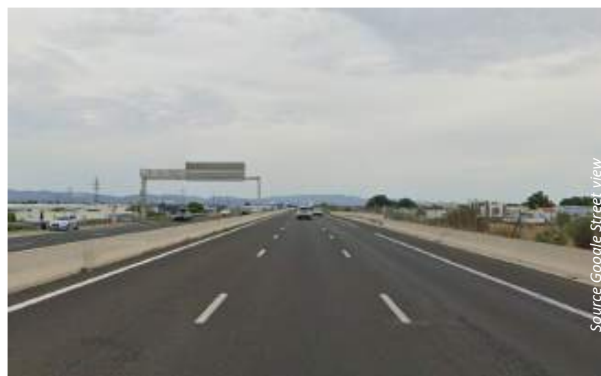
A9, entrepôts et espaces de stockage perçus depuis la route.
