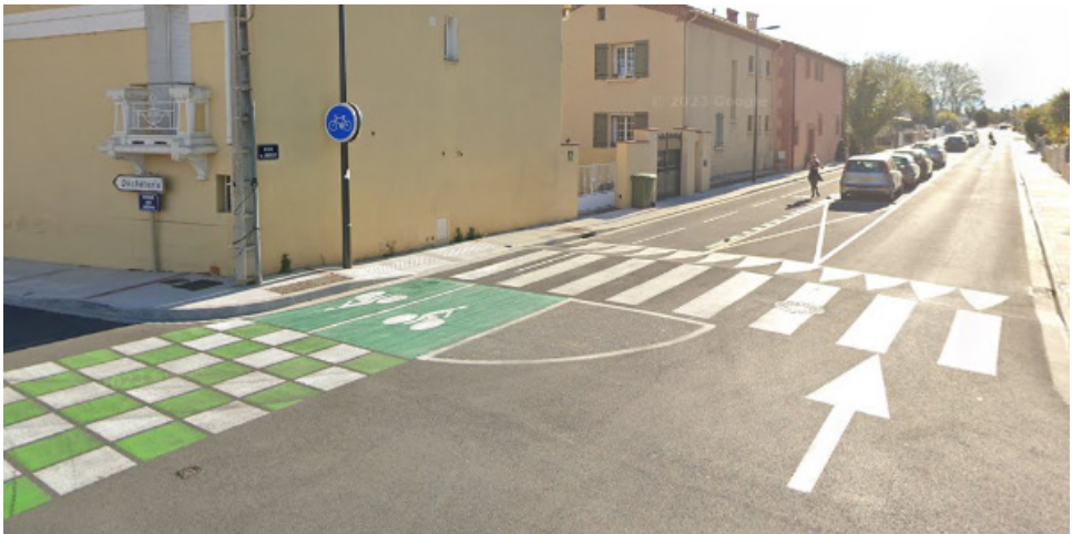
Rue des Jonquilles (Saint-Estève) : une rue de quartier composée d'un sens unique pour la circulation routière, de trottoirs et d'une piste cyclable bidirectionnelle séparée de la file de stationnements par des séparateurs de voie. La traversée piétonne est traitée en plateau traversant (Google Maps, 2023).
