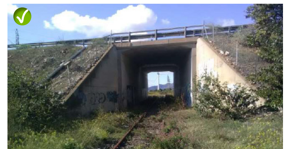
Pont cadre sous l'A9 à Rivesaltes. Ecotone®
