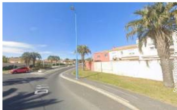
Séquence 3, murs de maison aveugles et éclairage inadapté
