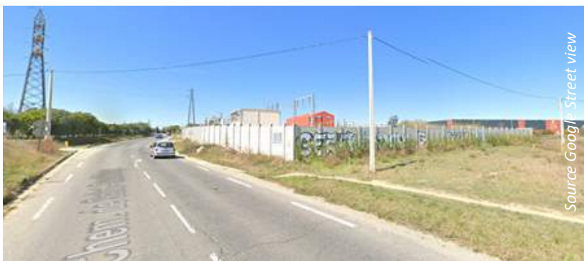
Séquence 2, murs aveugles du poste électrique au début de l'entrée
