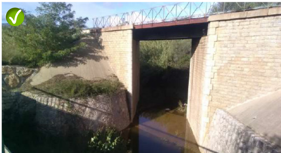
Pont cadre sous TPCF et RD69 à Tautavel. Ecotone®
