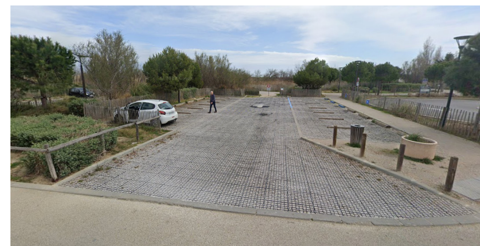
La Torre (Torreilles) : le sol du parking est poreux et permet les infiltrations tandis que de la végétation a été plantée autour des places de stationnement (Google Maps, 2023).
