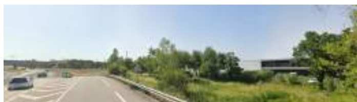
Séquence 1, perception de la zone économique depuis la bretelle d'accès sortie 3 RD612A
