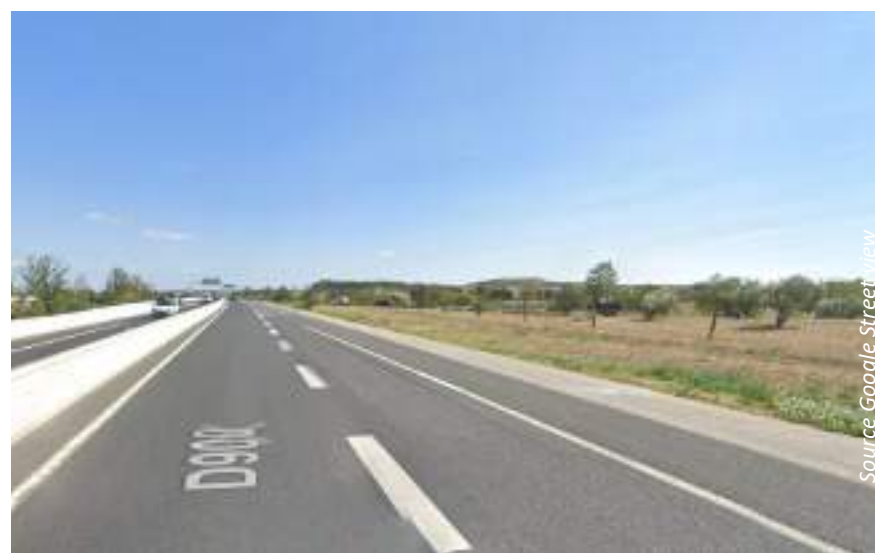
RD900, délaissé de voirie au bord à valeur paysager de la route.
