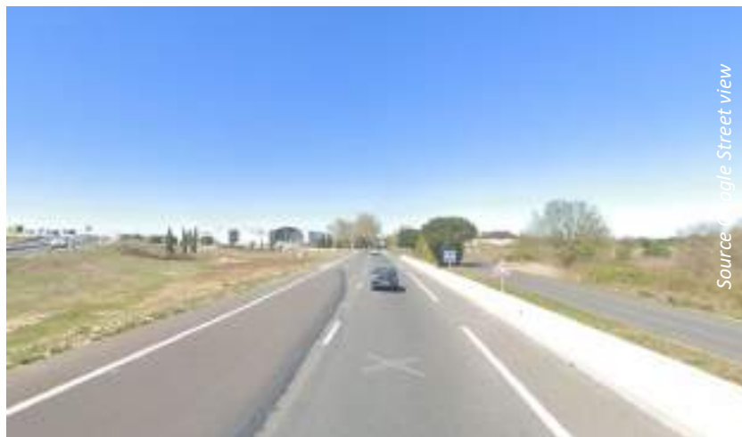
Séquence 1, Les grands bassins de rétention en entrée de ville.
