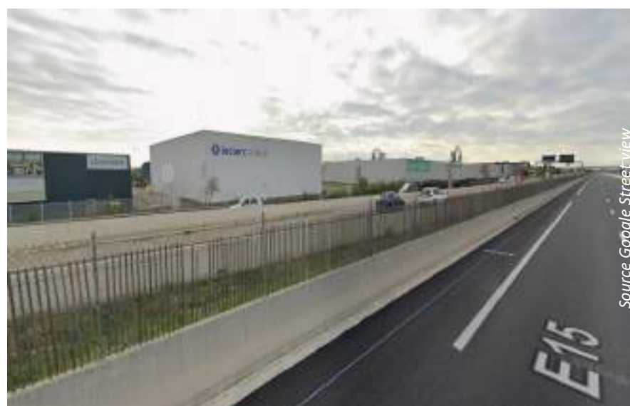
Vue à l'est sur les bâtiments commerciaux et leur clôture grillagée depuis la RD900
