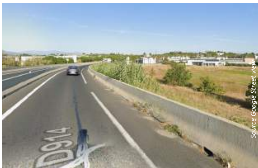
Un grand bassin de rétention en entrée de ville marqué par le front bâti de la zone commerciale
