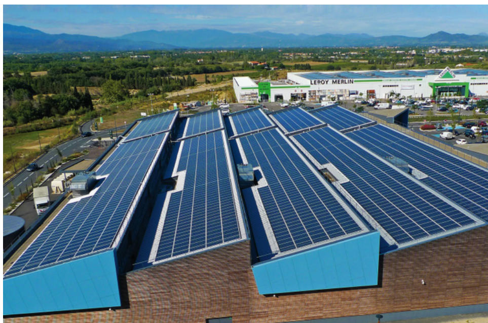
Exemple d'association de sheds et de panneaux photovoltaïques sur la toiture du magasin Boulanger, à Perpignan (66). Source : Magazine LSA.
