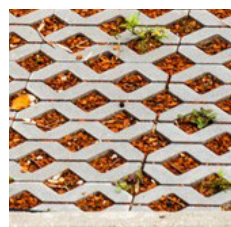
Dalle alvéolaire en béton et graviers
