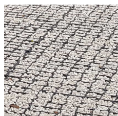
Dalle alvéolaire en béton et graviers
