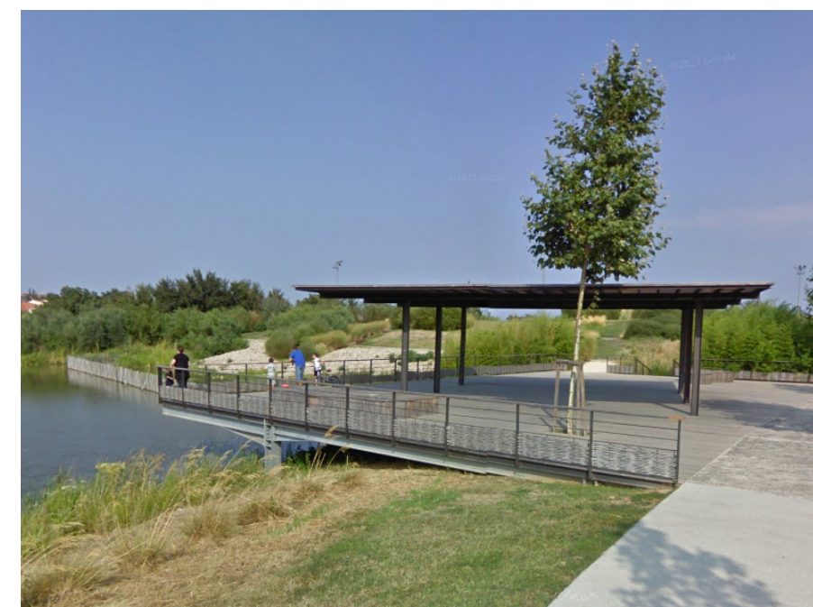
Exemple de terrasse bois en encorbellement sur bassin de rétention, Parc Sant-Vicens (Google Street View)
