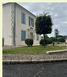
Espace public central de la commune - Laà-Mondrans
