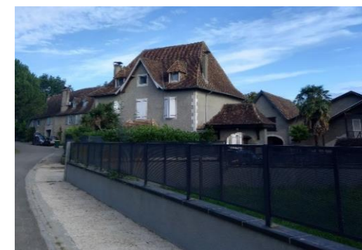
Lanneplaa : Utilisation de matériaux durables
