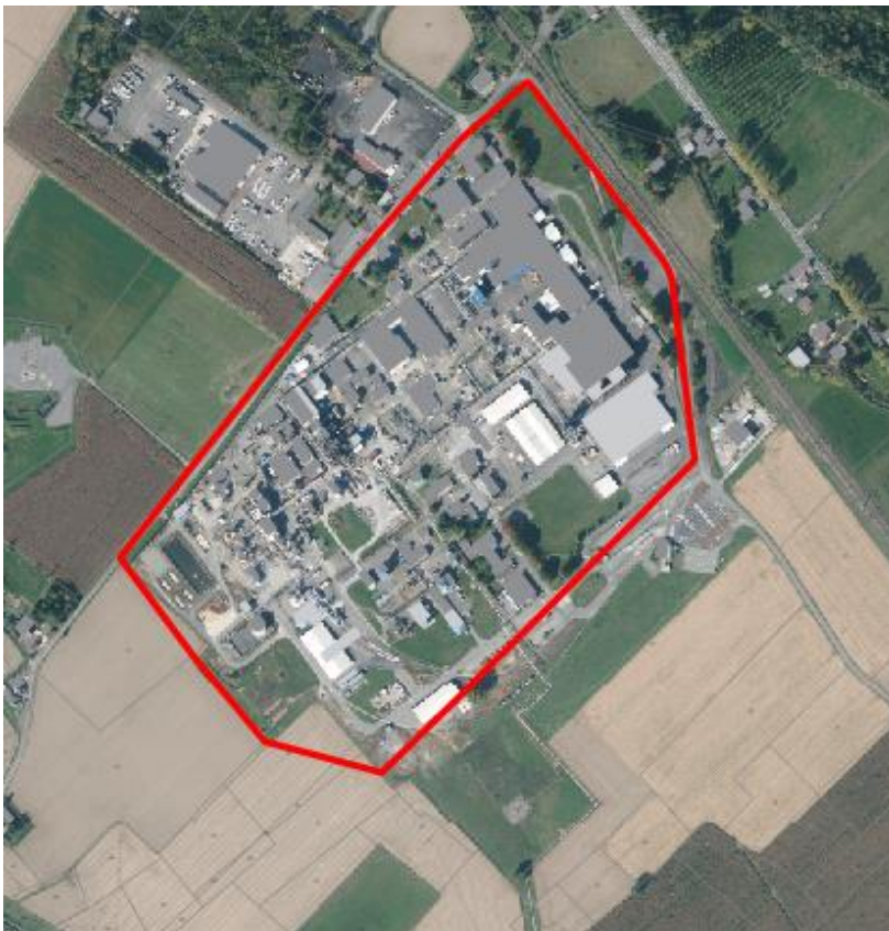
• Périètre clôturé de la plateforme industrielle et technologique de Mont
