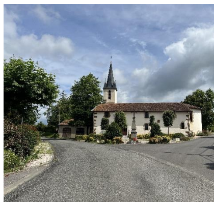
Espace public aménagé - Saint-Girons-en-Béarn
