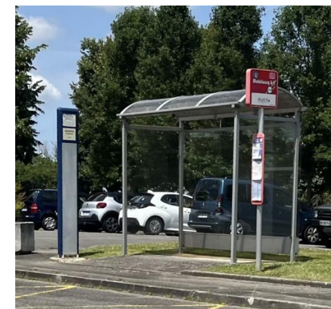
Abri bus commune de Noguères – arrêt 114 Tennis
