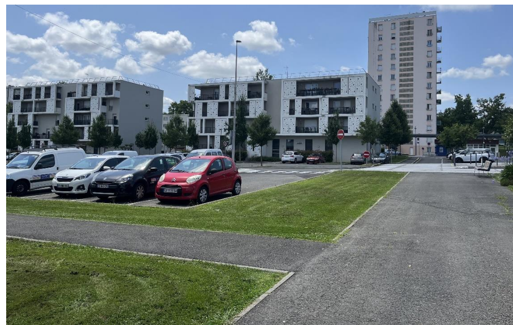
5 : Redynamisation des bâtis anciens, Ville de Mourenx
