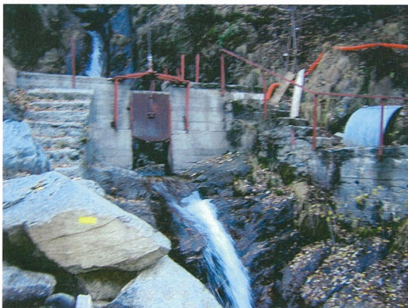
Photo 1 Prise d'eau, ouvrage limitant l'écoulement sur le Riou du Claï.
