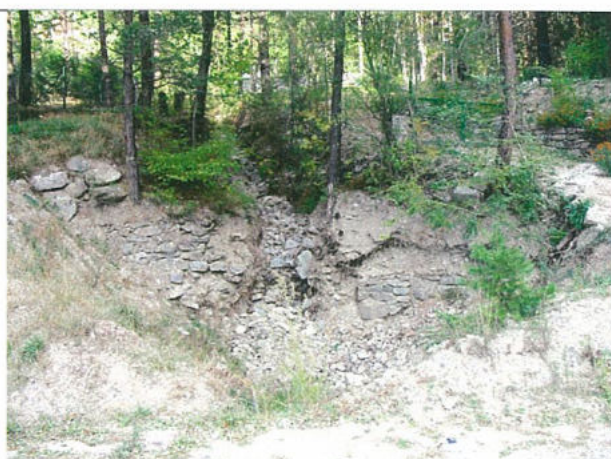
Photo 6 : limite torrent / RD 2205
