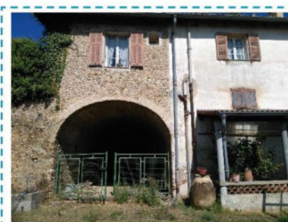
Passage voûté plein cintre
