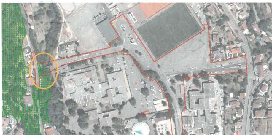
Figure 1 : Espace boisé classé concerné par le projet
