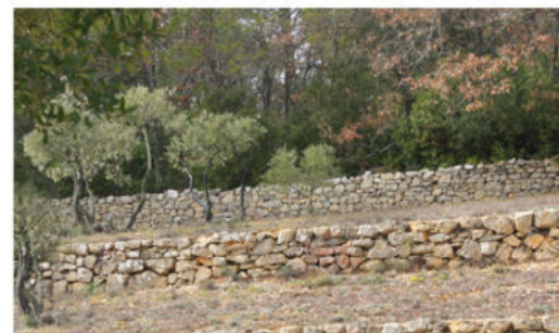
Restanque avec parement pierre
