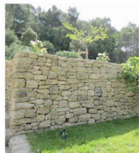
Restanque en pierres sèches
