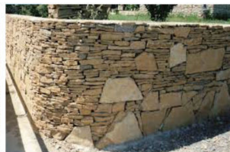
Restanque avec parement pierre
