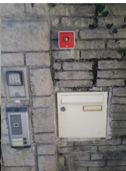
Photos 3 et 4 Installation de systèmes de déverrouillage réservés aux pompiers au niveau des deux portails de la liaison
