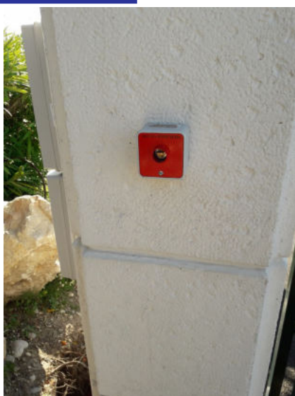
Photos 3 et 4 Installation de systèmes de déverrouillage réservés aux pompiers au niveau des deux portails de la liaison
