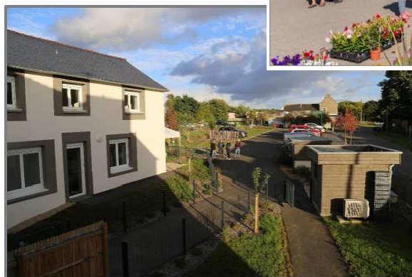
Réhabilitation d'une ancienne ferme à Tressignaux
