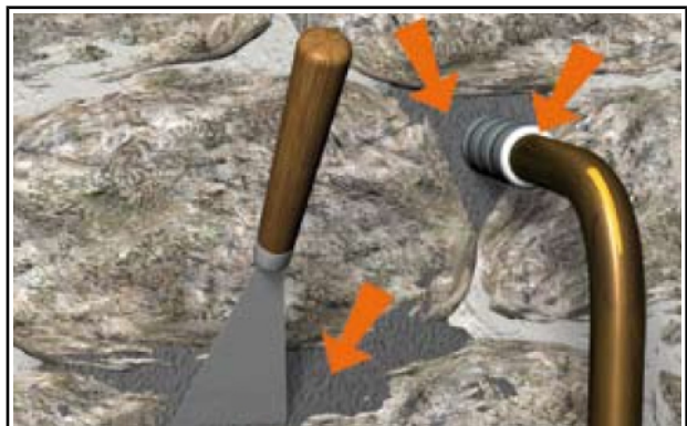
Situation après travaux de colmatage
