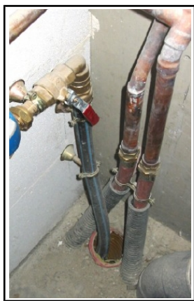
Exemple d'entrées de réseaux à calfeutrer
