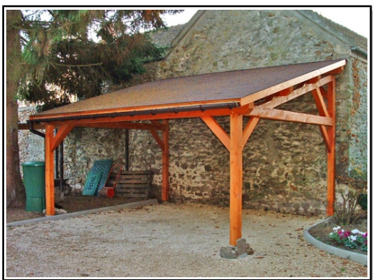
Construction annexe adossée à façade
