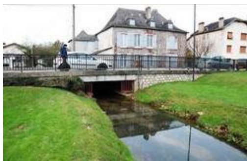
FIG. 22 : Ouvrage de franchissement Rue Tristan DERE ME
