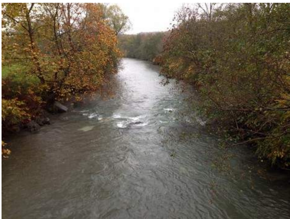
Seuil du pont Lavigne
