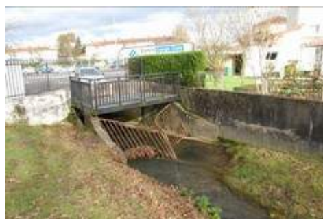
FIG. 18 : Ouvrage et canalisation de la « Mielle »
