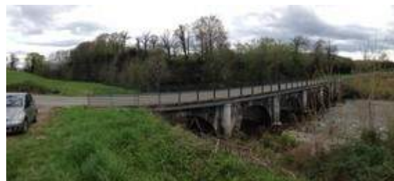
Pont sur la RD 24
