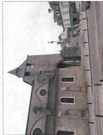
Le clocher-porche d'origine romane et son imposant pilier nord-ouest consolidé au XVII e siècle (cl. C. Herbaut)
