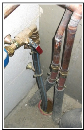
Exemple d'entrées de réseaux à calfeutrer
