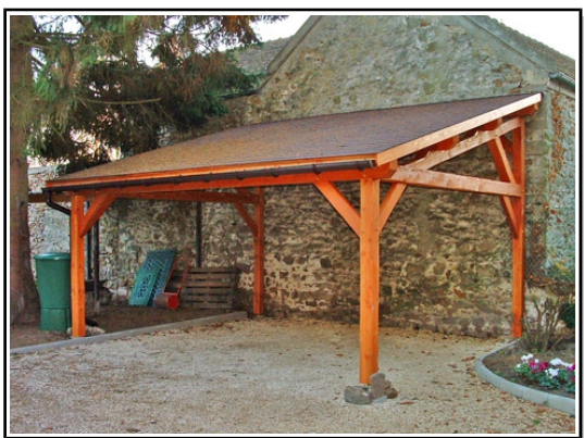
Construction annexe adossée à façade
