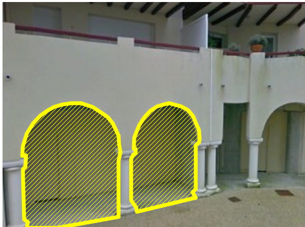
Obturation d'une travée de galerie
