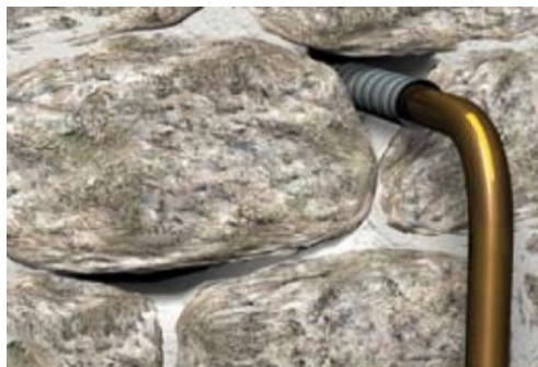
Situation initiale avant colmatage
