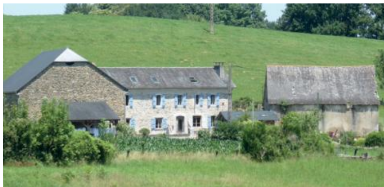
Photo 17 : Ferme à cour spacieuse isolée dans la campagne, présentant plusieurs corps de bâtiment séparés sur la commune de Lurbe-Saint-Christau - Pays d'Art et d'Histoire Pyrénées Béarnaises
