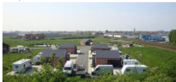
Figure 140 : Aire d'accueil de Bailleul-Nieppe (CCFI 2018)
