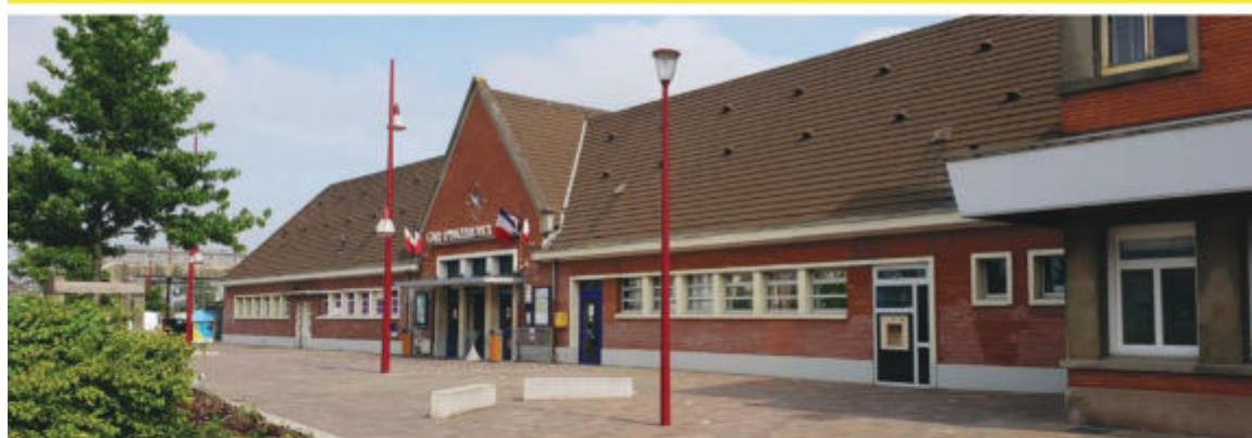
Vue sur la gare côté parvis - Hazebrouck
