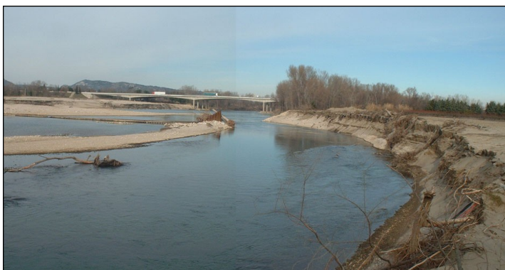
Contournement du seuil de la Rouquette, en aval de l'autoroute A 9
