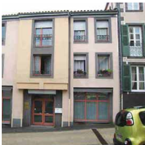
Immeuble d'habitation à Mezel
