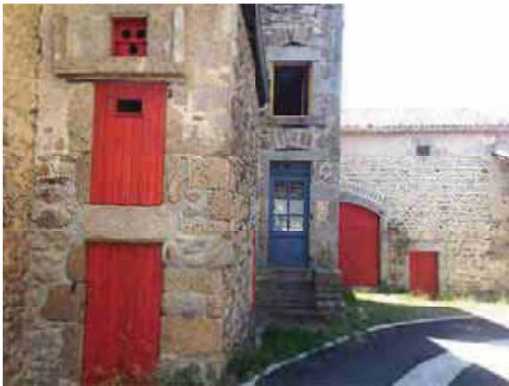
Traitement des ruelles de St-Jean-des-Ollières
