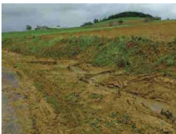
Egliseneuve-près-billom (route vers l'étang de la Croix Percée) : fossé bouché par les coulées de boues et passage des engins de nettoyage des routes jusqu'à trois semaines après les inondations
