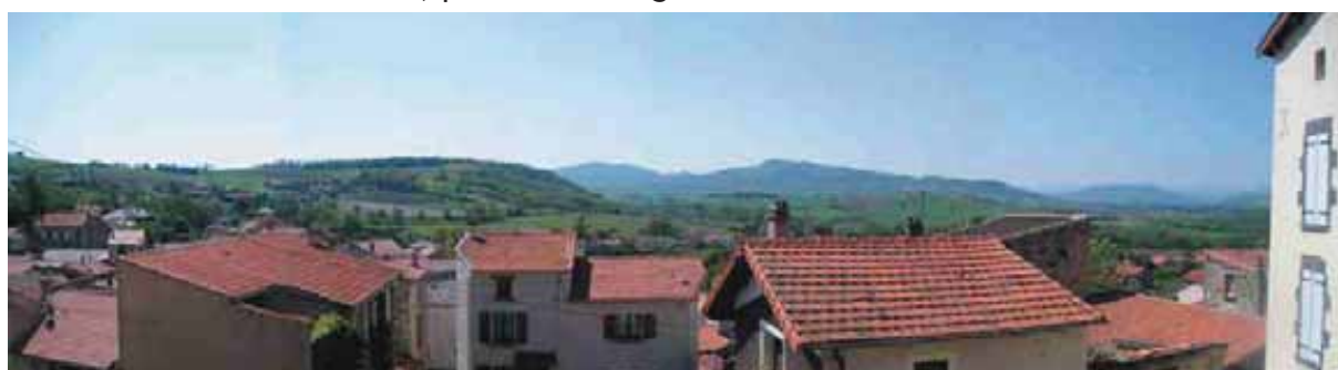
Vue sur le val d'Allier depuis Mezel (Cf. Charte CC Mur-ès-Allier - Vallée du Jauron)
