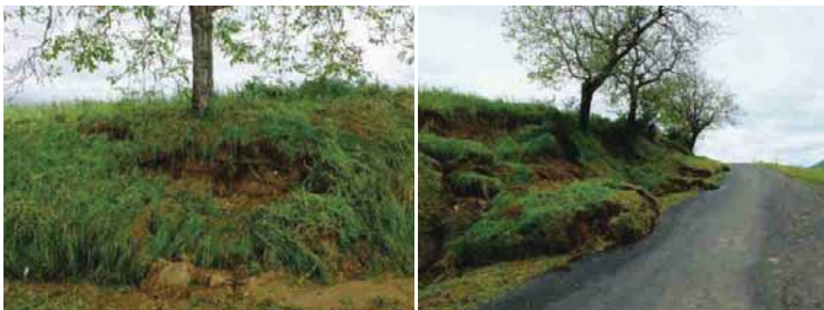
Egliseneuve-près-Billom Route vers Le Mas, talus effondré et noyer et Route de la Croix Percée, talus effondrés le long de la route avec noyers
