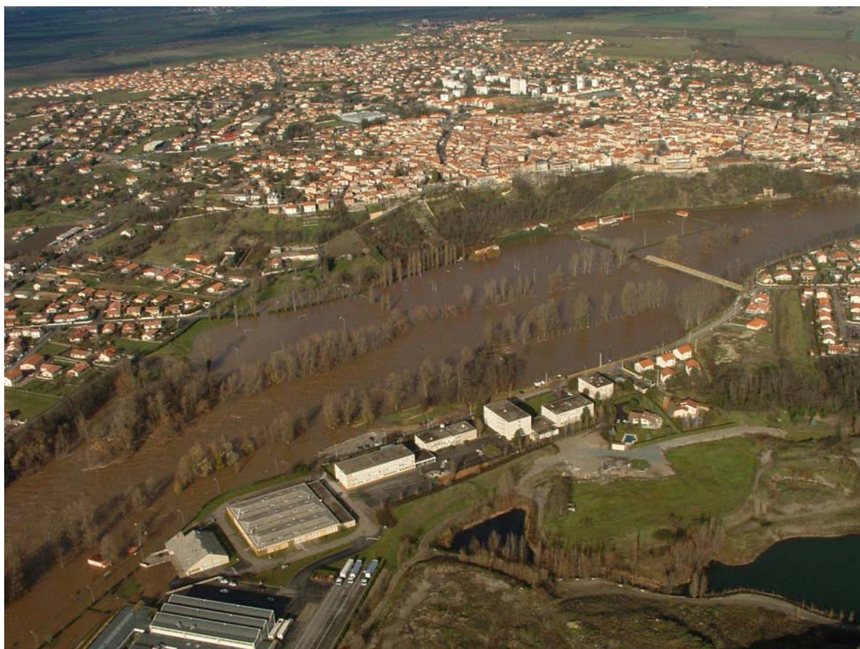
Crue des 3 et 4 décembre 2003 à Pont-du-Château
