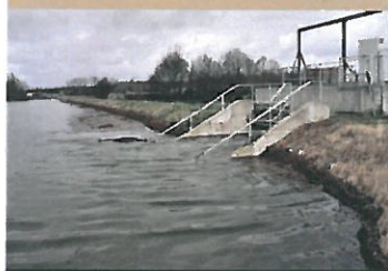
La digue d'Ouroux-sur-Saône (71)
