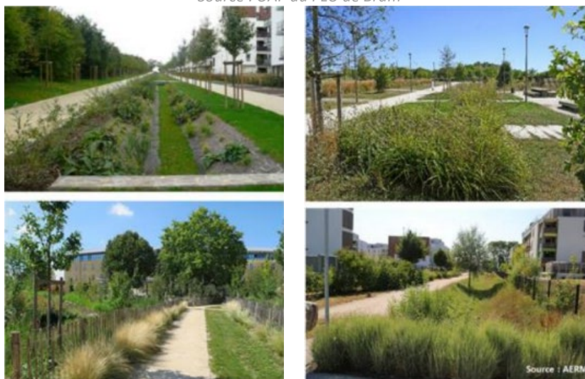
Figure 3 : Exemples d'aménagements de voies douces, de noues végétalisées et de bassins d'orage
