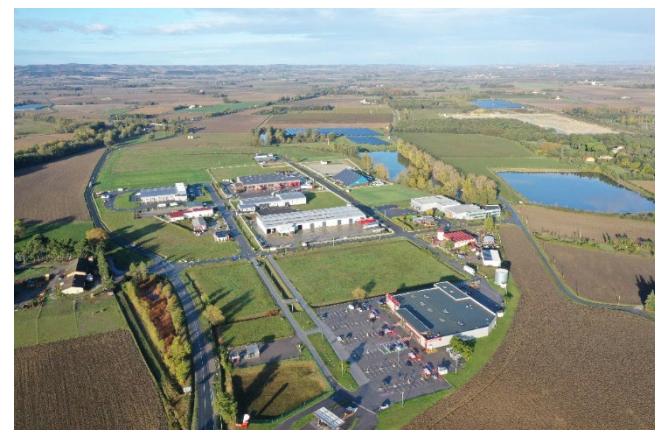
Figure 48 : Vue aérienne de la Zone d'activités intercommunale, source : Mairie de Bram
