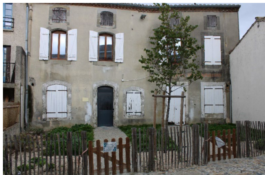
Figure 122 : photographies de façades de logements dans le centre-bourg de Bram, source : Paysages
