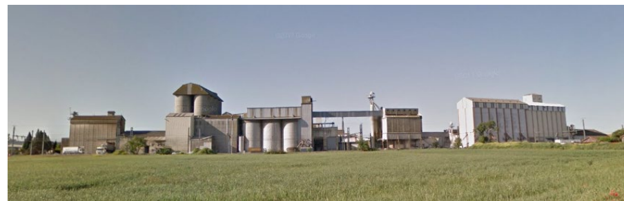
Figure 92 : L'arrière de la société coopérative agricole Arterris, source : Google Street View
