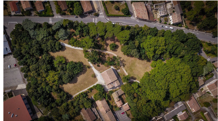
Figure 107 : Vue aérienne du parc des Essars, source : Mairie de Bram
