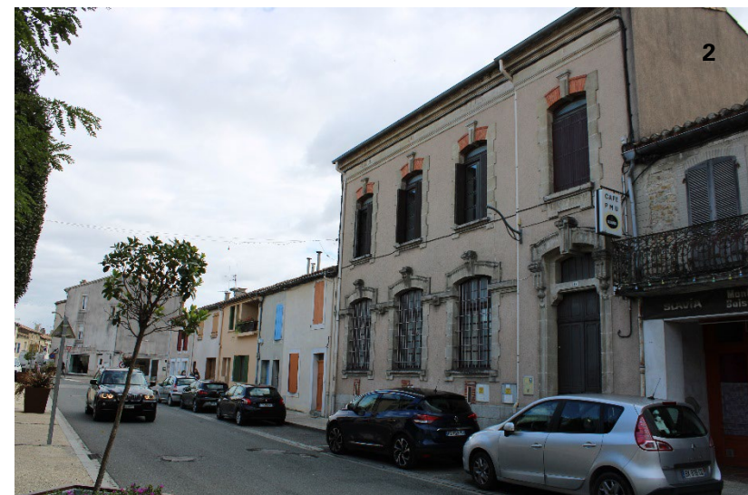
Figure 140 : Grange de la rue Charles de Lordat (1), Ancienne école de Filles (2), Bâtisse Place du Foirail (3), source : photographies Paysages octobre 2020
