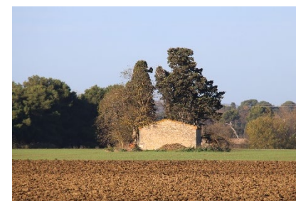
Bâti agricole en ruine
