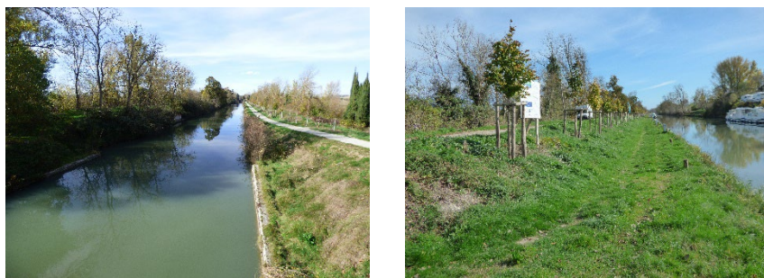
Canal du Midi et ses abords au niveau du port de Plaisance au Centre-Nord de la commune
