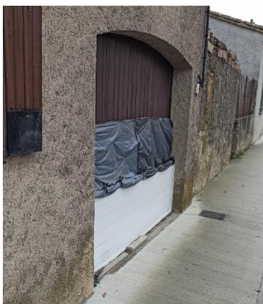
Figure 5 : Dispositif mis en place par les riverains
