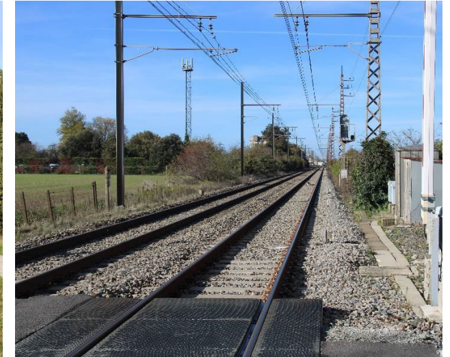
Voie ferrée de Bram, ARTIFEX, (18-11-2020)
