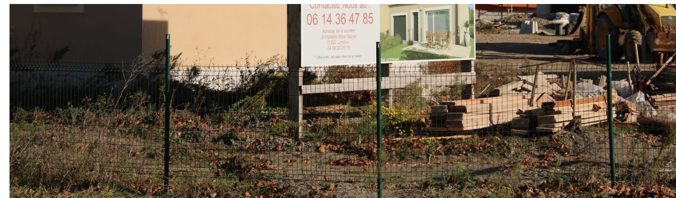
Exemple de clôture non jointive au sol au niveau du nouveau lotissement sur la RD4 (Est de la ville)
