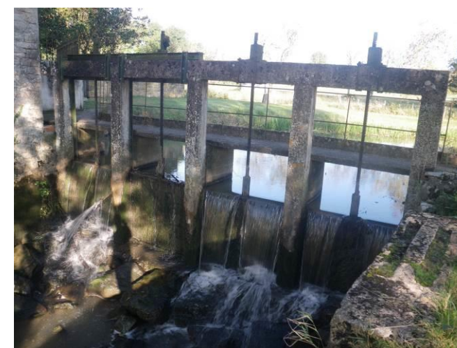
Photographie 16 - Seuil sur la Noue
