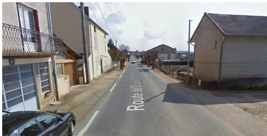
Trottoirs non matérialisés, absence de passage piéton et de marquage au sol, absence de piste cyclable, route rectiligne ne faisant pas ralentir les automobilistes [Entrée Nord de Cormatin].
