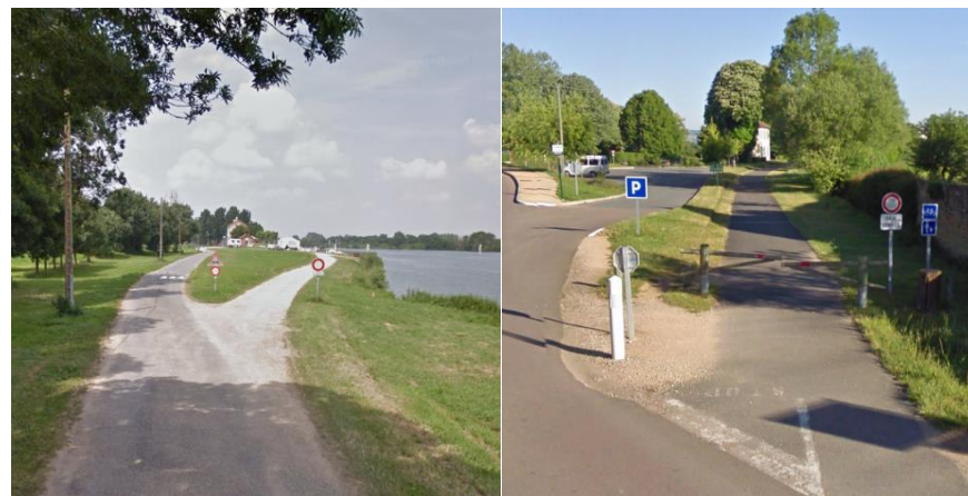
Aménagements des voies bleue « Echappée bleue » (à gauche) et verte « Tour de Bourgogne » (à droite)
