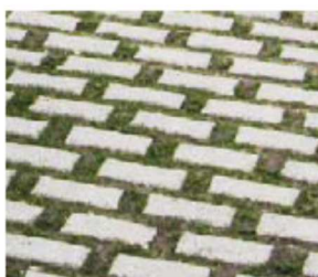
Pavage en béton avec ouvertures de drainage
