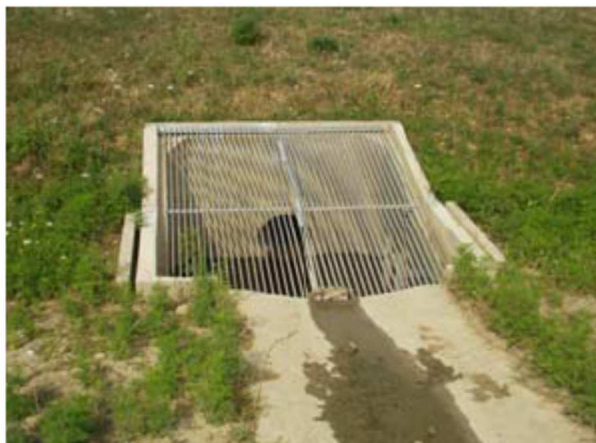
Grille de protection sur ouvrage de sortie
