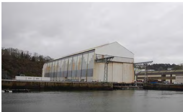
Cale du Point-du-Jour
