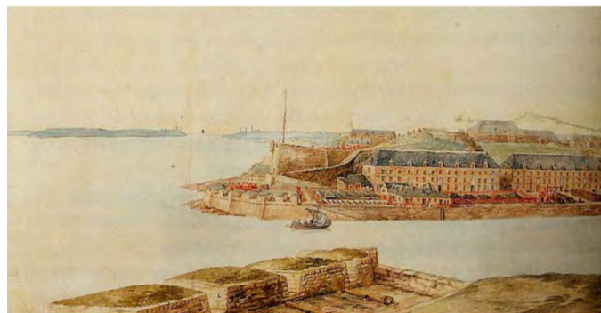
Entrée du port, prise du château. Détail de la batterie du fer à cheval © Archives municipales et communautaires de Brest
