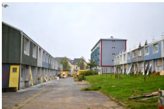
Démolition de l'îlot Nungesser – Photo Brest métropole
