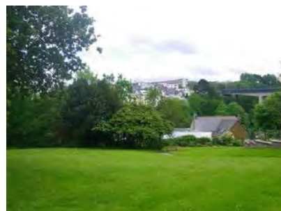
Le pont Schumann enjambe cet encaissement du relief
