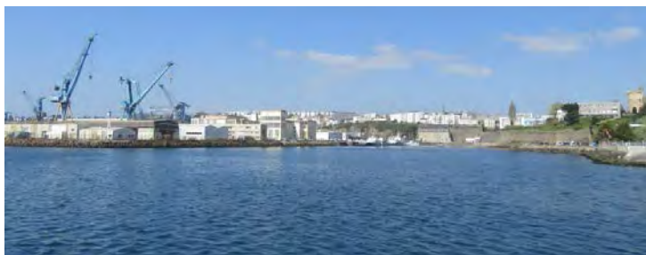
Point de vue de l'entrée du port militaire en Penfeld depuis la digue Jean-François de la Pérouse
