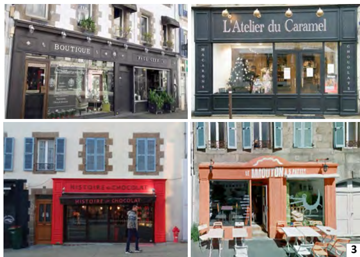
2 Bons exemples de vitrines commerciales sur des bâtiments de la reconstruction.
