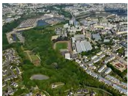
Vue aérienne de Kervallon
