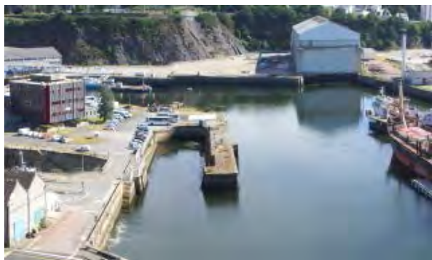
Demi-forme de radoub du Salou (bassin n°6)
