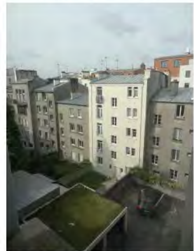
FAÇADE SUR COUR
