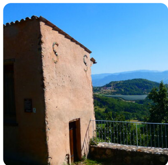
Enduit au plâtre (UPAIX)
