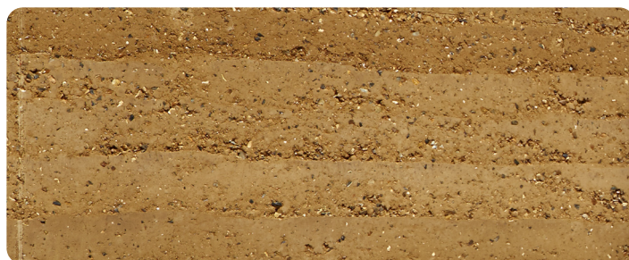
Mur en terre crue banchée (pisé)
