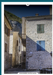
10 Modifications d'ouvertures en façade
