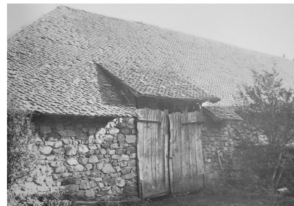
Toit en tuiles écailles, Charbillac. © Roger Isoard, Habiter la montagne
