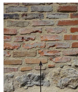
Tout venant à enduire Les différents matériaux indiquent la nécessité d'un recouvrement par enduit.
