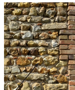
Tout venant à enduire Les différents matériaux indiquent la nécessité d'un recouvrement par enduit.
