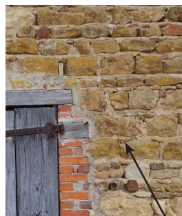
Tout venant à enduire Les différents matériaux indiquent la nécessité d'un recouvrement par enduit.
